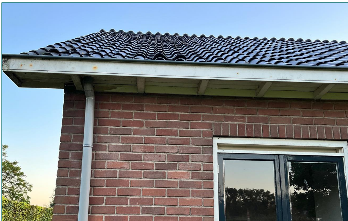
Figuur 2 De woning bestaat uit bakstenen muren met luchtsponw en een dakpannen dak.
