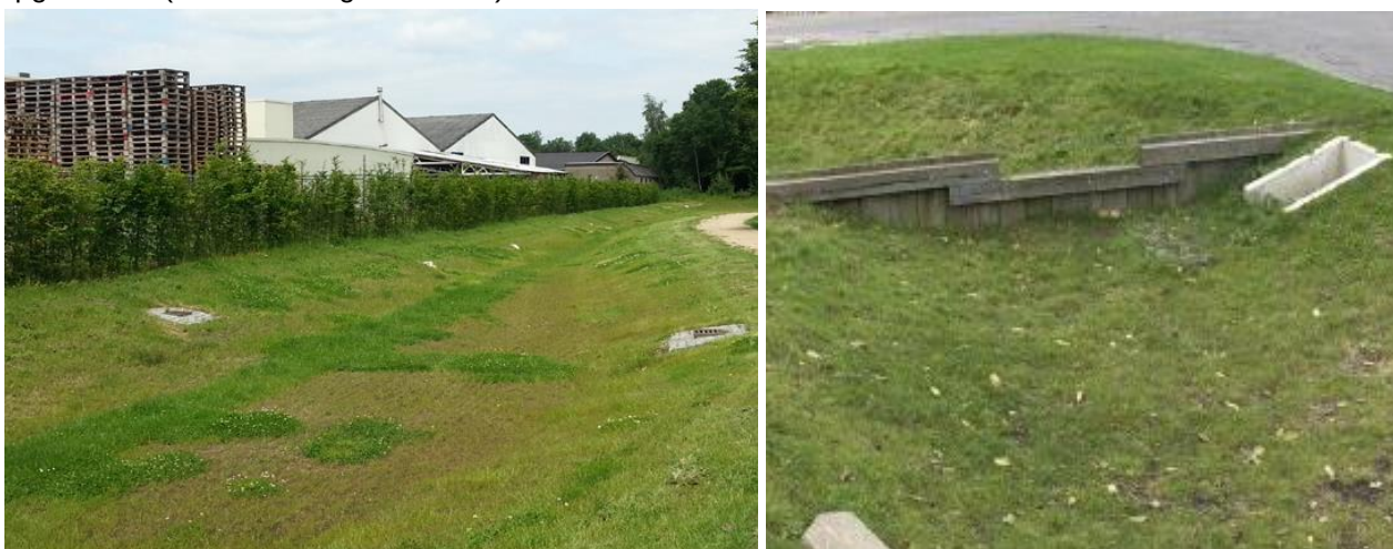
Afbeelding 9 en 10: Toepassingsvoorbeeld en mogelijke stuw met overloop
