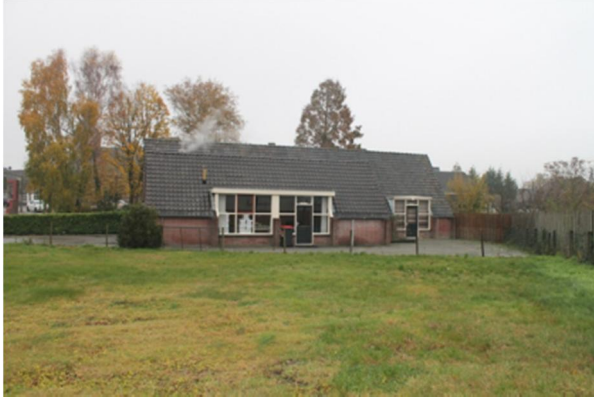
Afb. 2: Huidige bebouwing (bron: foto Kragten)
