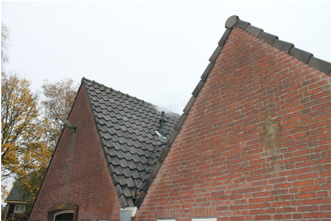
Afbeelding 3: Hoekpannen waar vleermuizen onder kunnen kruipen om de schouw te bereiken (Foto's Kragten).
