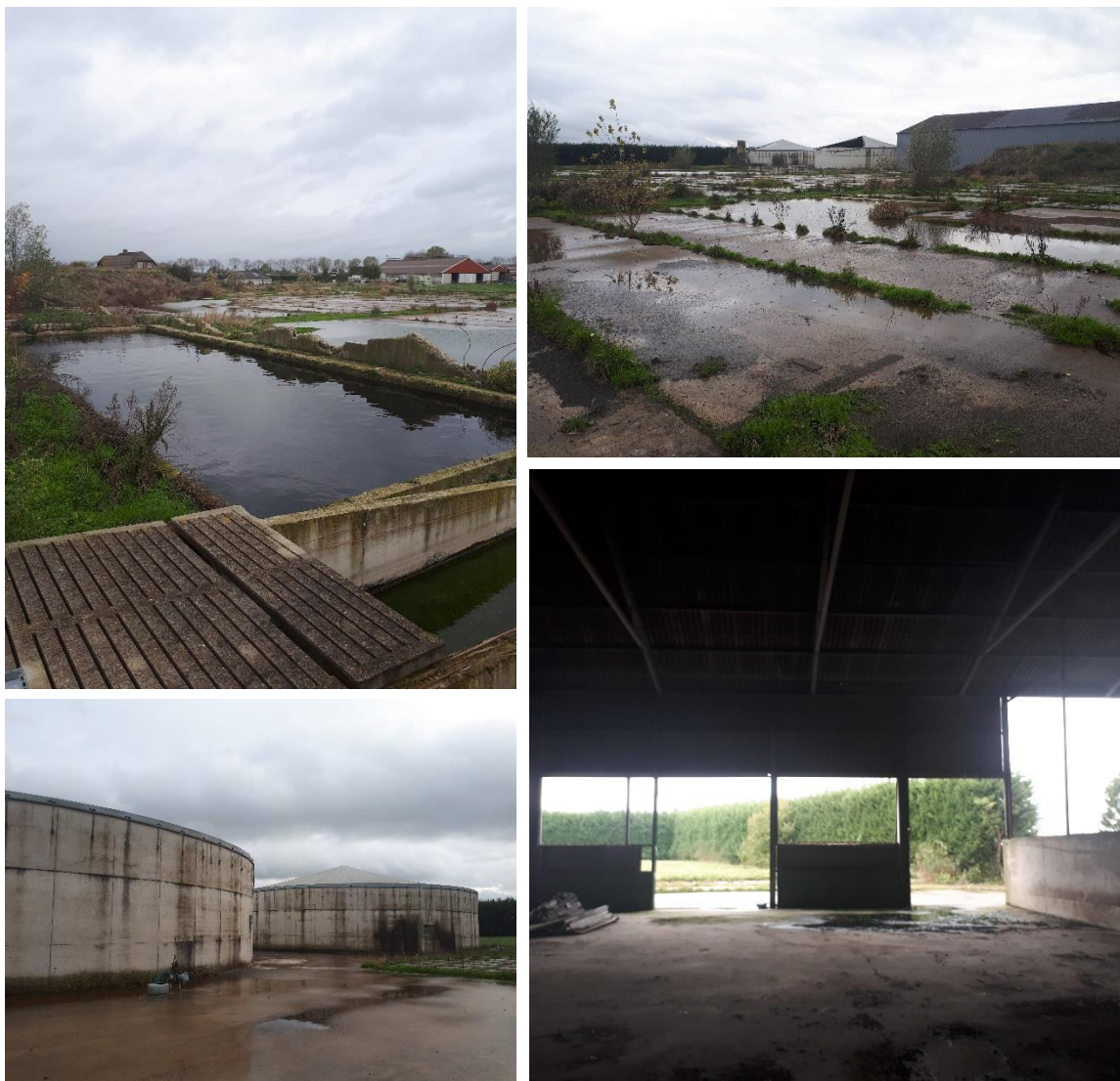
Figuur 3. Met water gevulde fundamenteën (linksboven), overzicht van het verharde terrein met de grote schuur en silo's op de achtergrond (rechtsboven), aangezicht van twee silo's (linksonder) en de binnenkant van de grote schuur (rechtsonder).
