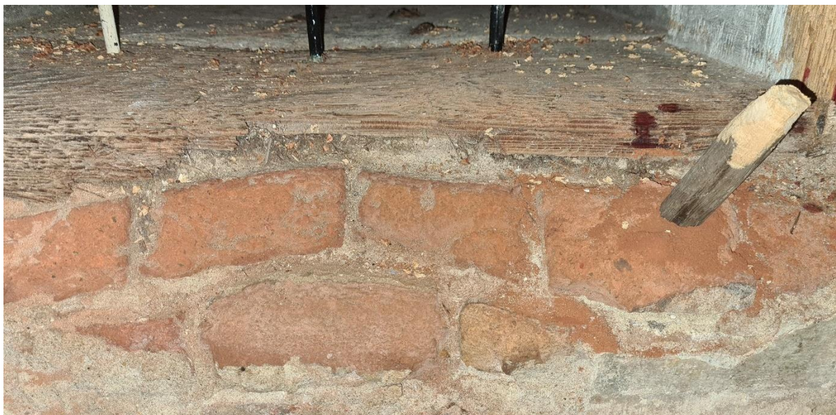
Afbeelding 7. Deel van de keldervloer
