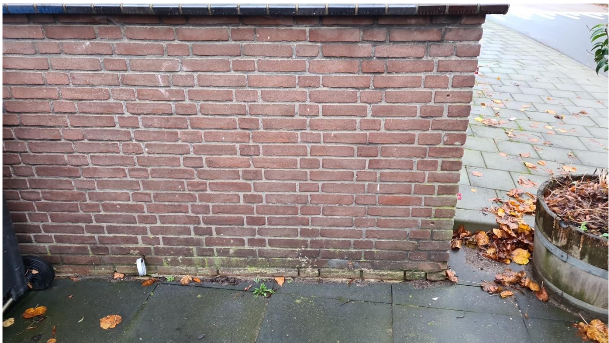
Afbeelding 6. Deel van de oostgevel (noordelijke deel onder serre-raam).
