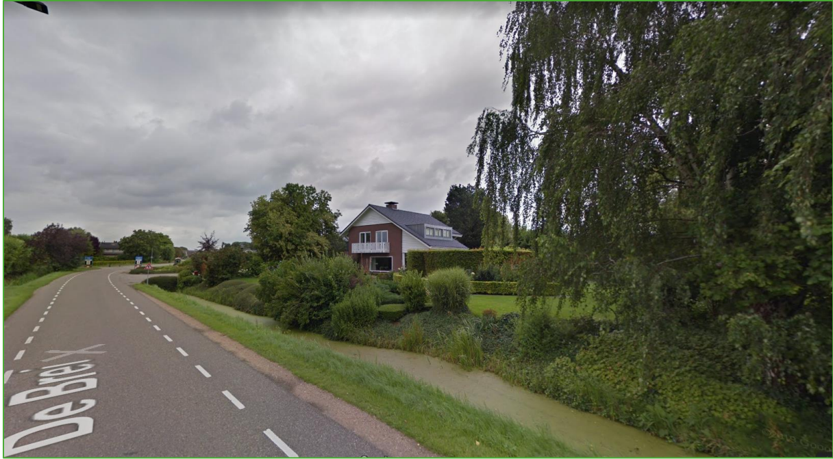
Figuur 2.4: Aanzicht zuidzijde plangebied, dit aanzicht wijzigt niet in de nieuwe situatie.
