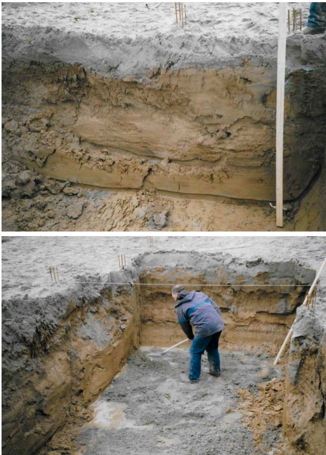
Figuur 35: Foto's bij bouwwerkzaamheden in deelgebied A.
