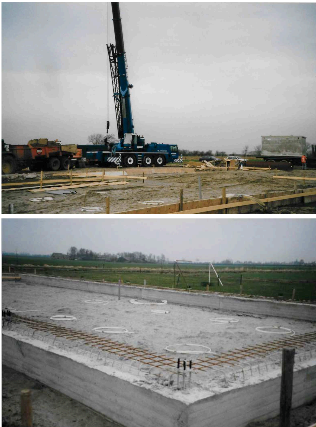
Figuur 36: Foto's bij bouwwerkzaamheden in deelgebied A.
