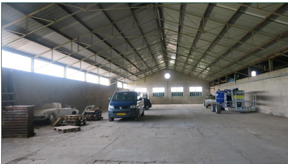
Figuur 4 De binnenzijde van de te slopen loods (4).
