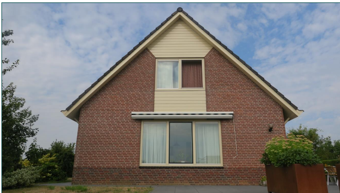
Figuur 3 De te slopen woning (1).
