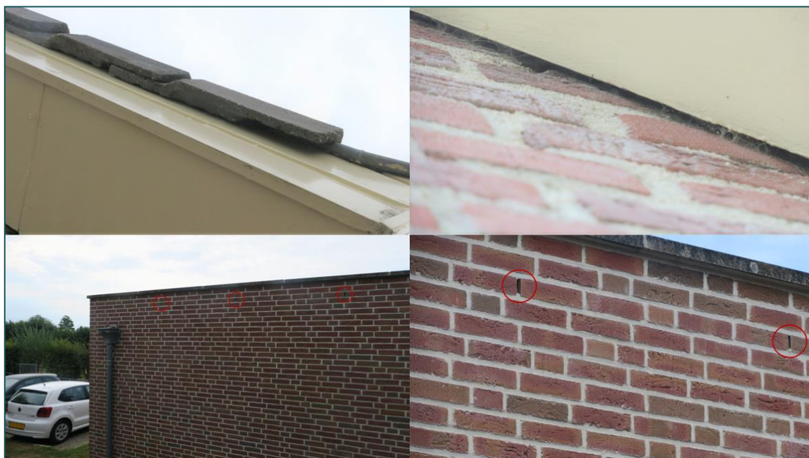
Figuur 3.1 De dakruimte en de luchtsponw van de woning zijn toegankelijk via de kantpannen en het kierende overstek (boven). De luchtsponw van de receptie is toegankelijk via stootvoegen (aangegeven met de rode cirkels; onder).
