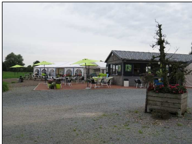
Foto 1: Te slopen bebouwing
