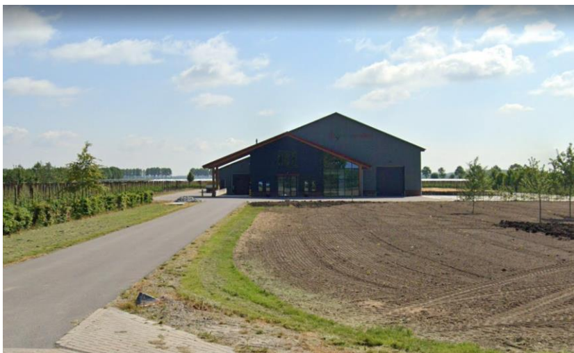
Vooraanzicht bestaande situatie (vanaf de Culemborgseweg)
