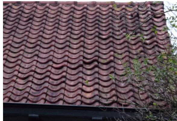
Fig. 10. Openingen onder dakpannen van te slopen bebouwing, binnen plangebied
