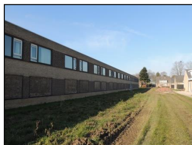
Figuur 7. Oostzijde van de onderzoekslocatie.
