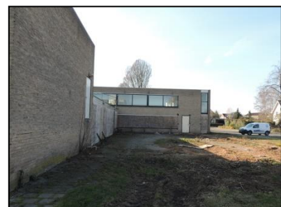
Figuur 8. Noordzijde van de onderzoekslocatie.
