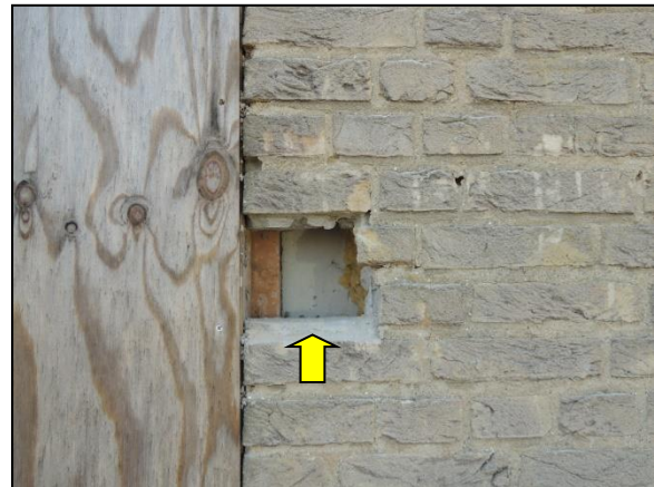
Figuur 11. Gaten bieden toegangsmogelijkheden tot de spouwmuur.
