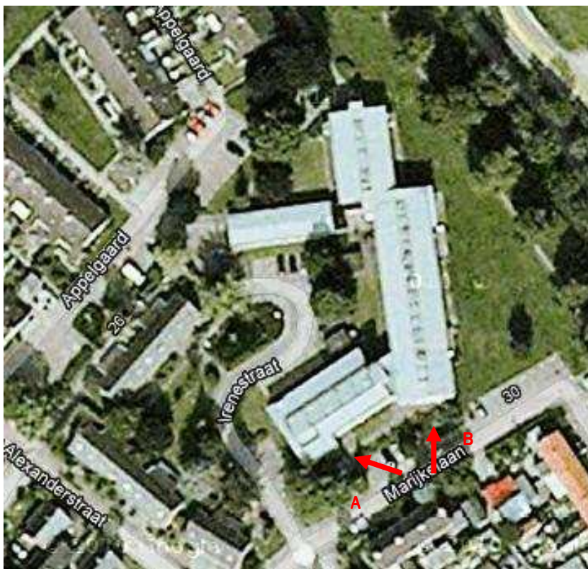
Figuur 4.2: Appartementencomplex Appelgaard. Rode pijlen geven de richting waarin de onderstaande foto's zijn genomen.
