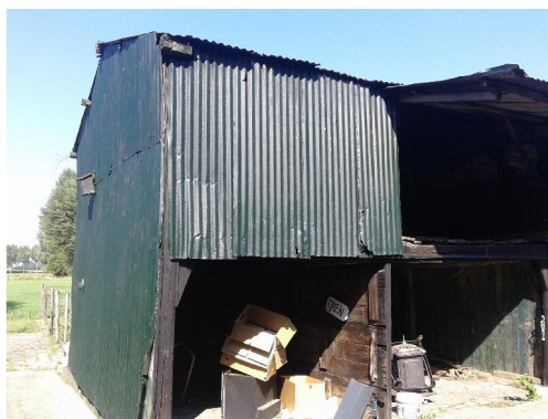
Foto: detail vooraanzicht te revitaliseren bijgebouw
