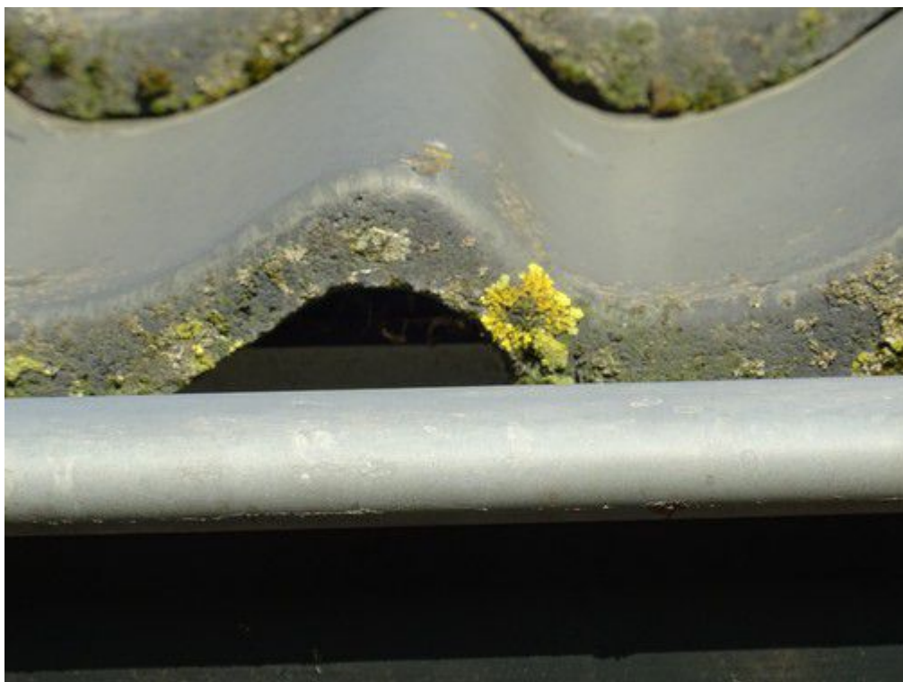
Ruimte onder dakpan met aanwezig nestmateriaal
