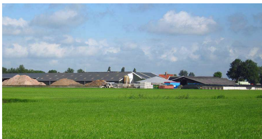
Zicht op de mest- en voeropslag aan de achterzijde van het erf.
