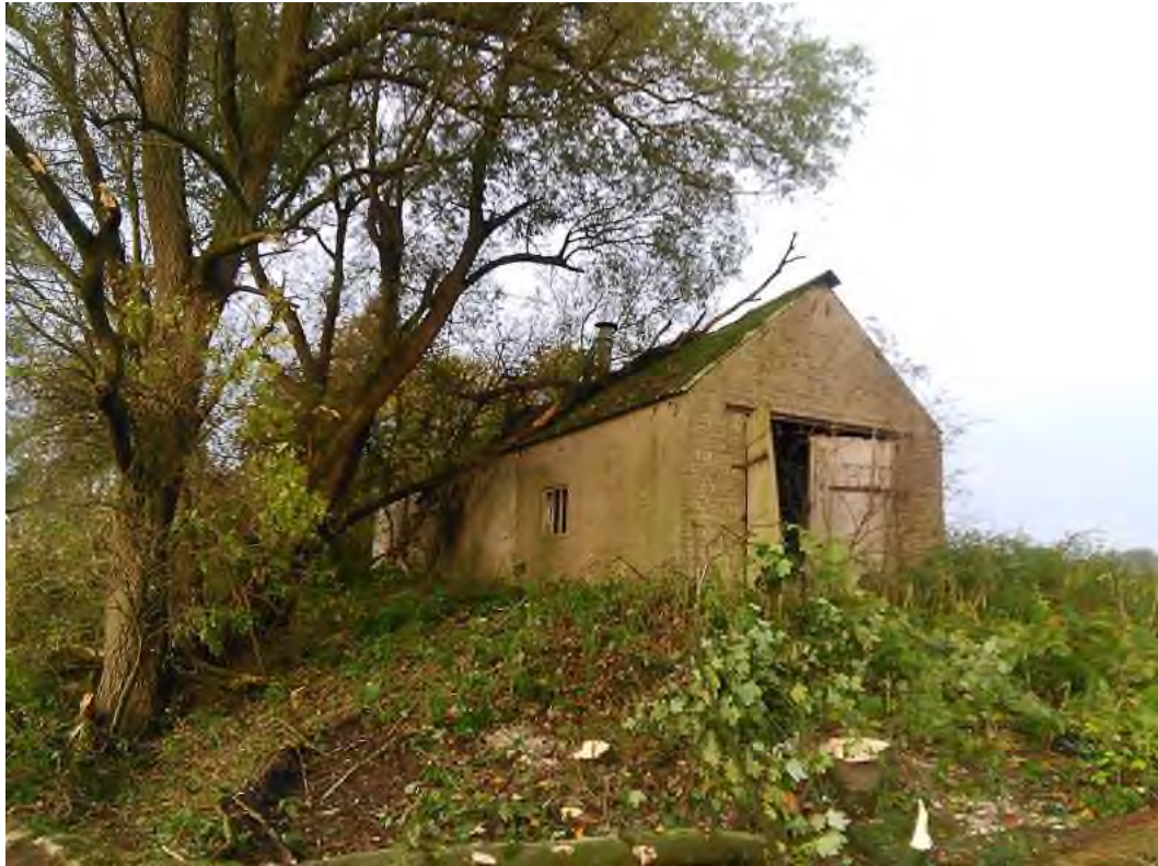
Foto 1 Omschrijving foto 's locatiebezoek 21-10-2015 Naam P15-0559-026 foto 017 werkplaats.jpg Opnamedatum 21-10-2015 10:11
