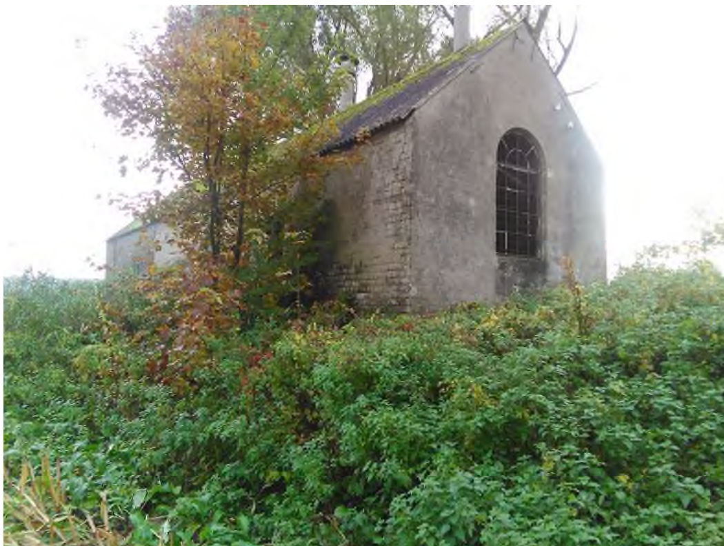
Foto 3 Omschrijving foto's locatiebezoek 21-10-2015 Naam P15-0559-028 foto 026 werkplaats.jpg Opnamedatum 21-10-2015 10:15
