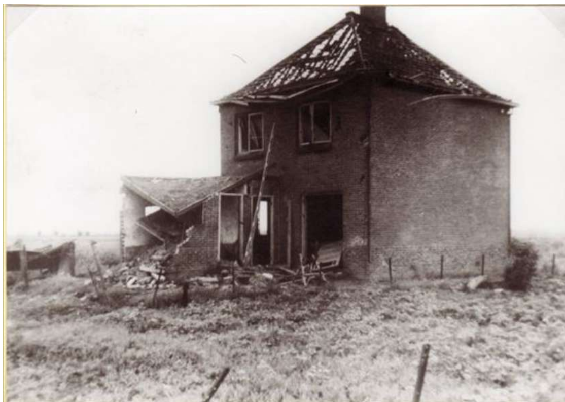
Foto 4 Naam P15-0559-023 1944_foto 4 oostelijk gelegen woning.JPG Opnamedatum 23-10-2015 13:28
