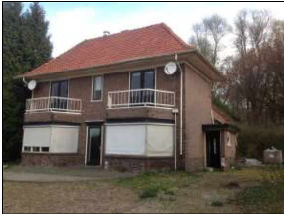
Foto 1. Gebouw met nesten
