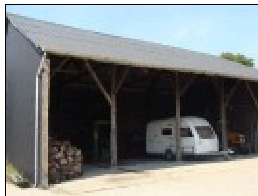
Foto 4. Te slopen kapschuur
