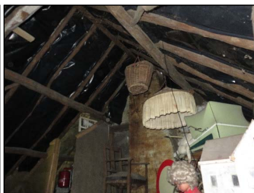
Foto 2. Zolder boven oude woning
