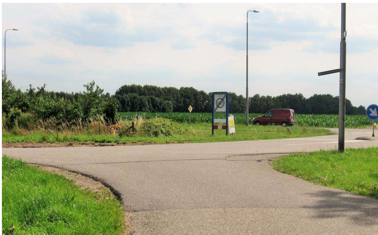
Figuur 4. Westelijke begrenzing van de 60 km/uur-zone met aansluiting van de Woerd en de Woerdsestraat (voorgond) op de N834. De rode bestelauto rijdt op de N834.
