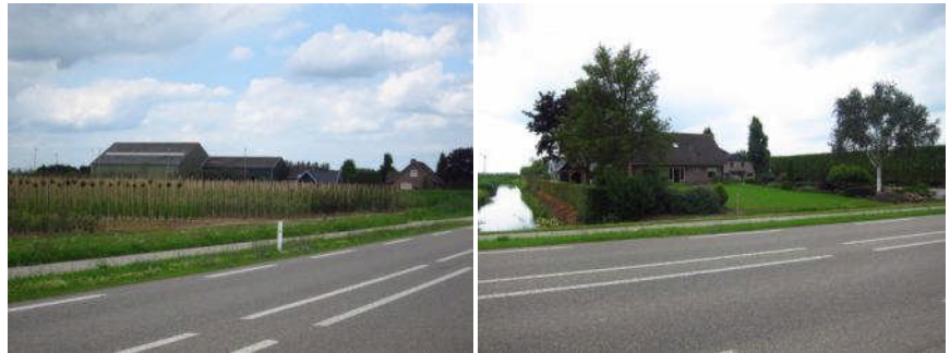
Aanzicht van de planlocatie vanaf de oostzijde (links) en de voorzijde.
