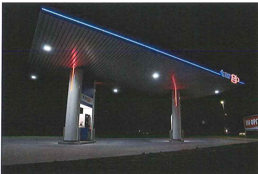
AVOND-NACHT VERLICHTING GEDIMD - LED VERLICHTING (6 X 30 W) *)
