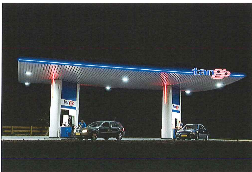
AVOND-NACHT VERLICHTING IN BERDIJF - LED VERLICHTING (6 X 80 W) *)
