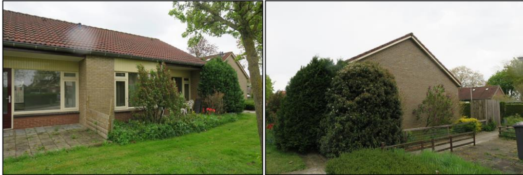
Figuur 6 Complex E bestaat uit bruine gemetselde muren met spouw. Verder is er een zadeldak met overstek aanwezig.
