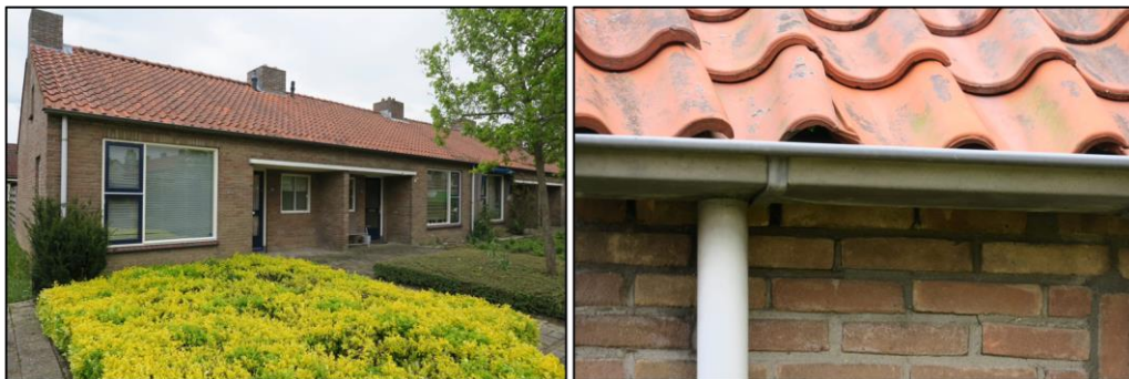
Figuur 5 Complex D betreft gemetselde muren met spouw en een rood zadeldak.
