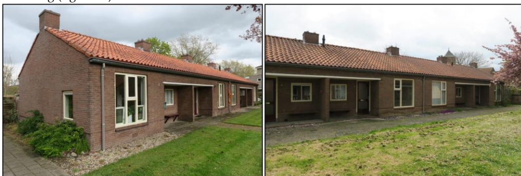
Figuur 2 Complex A betreft gemetselde muren met spouw en een zadeldak met dakbeschot.
