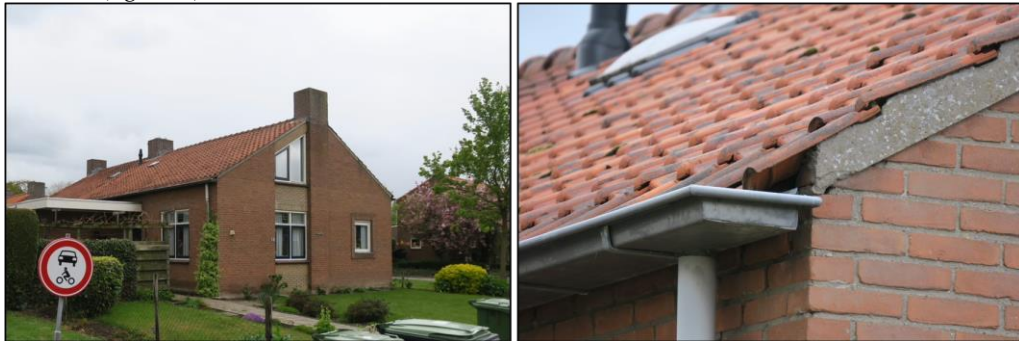
Figuur 4 Complex C betreft gemetselde muren met spouw en een rood zadeldak.
