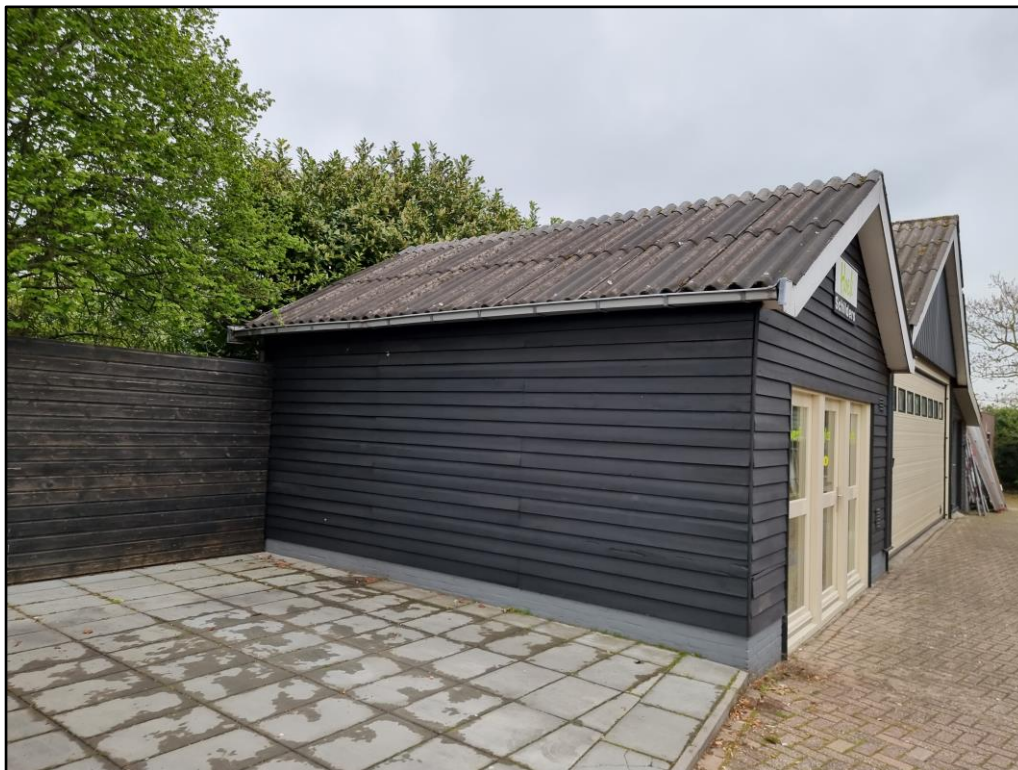
Figuur 2 Het eerste te saneren bijgebouw op de planlocatie, opgetrokken uit gemetselde muren met houten gevelbekleding en golfplaten dak.
