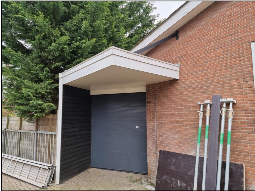
Figuur 3 Ten oosten van het te renoveren gebouw wordt een aangebouwde garage gesaneerd.
