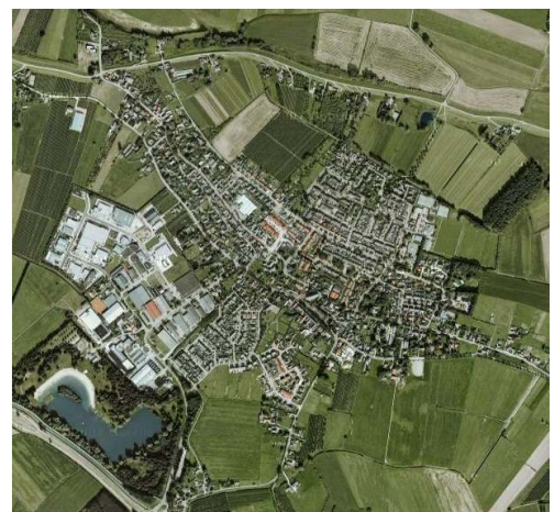
Luchtfoto huidige situatie
