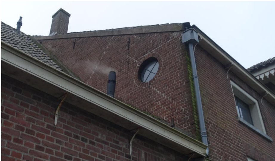
De twee vensters met vullingen op de verdieping van het deel van het krukhuus dat naar de Achterstraat is gericht behoren tot de bouwfase van de ophoging.
