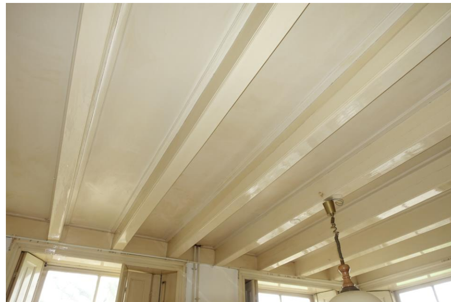
De enkelvoudige verdiepingsbalklaag in het woonhuis.
