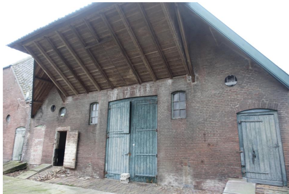
De indeling van de achterzijde van de oude schuur vertoont overeenkomsten met de achterzijde van de jonge schuur. Zijn de gevels tegelijkertijd in 1903 opgetrokken of is de schuur van 1903 gekopieerd naar de bestaande situatie?
