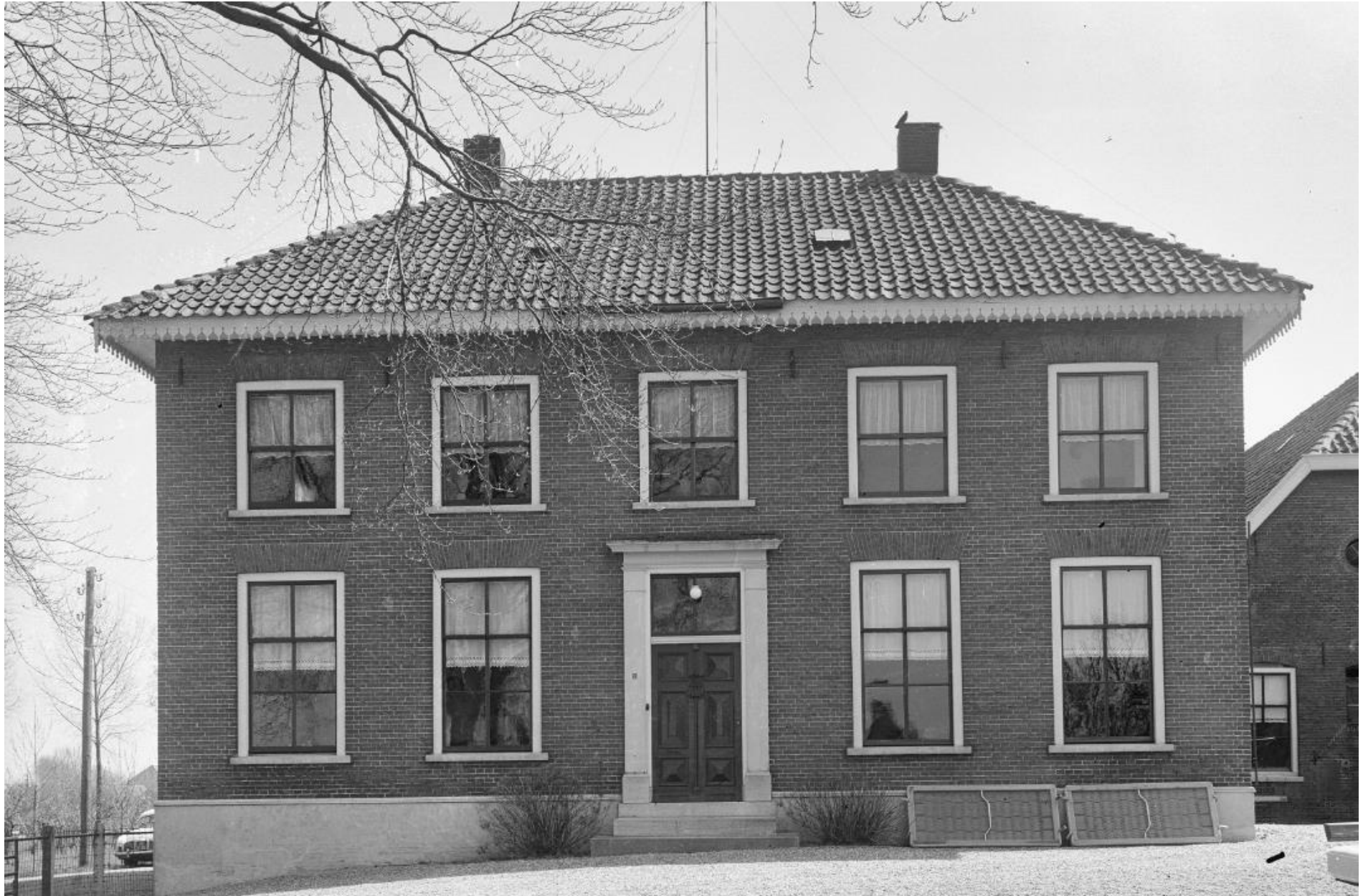
Foto uit 1966 van de voorgevel van het woonhuis. RCE beeldbank, nr. 103.150.
