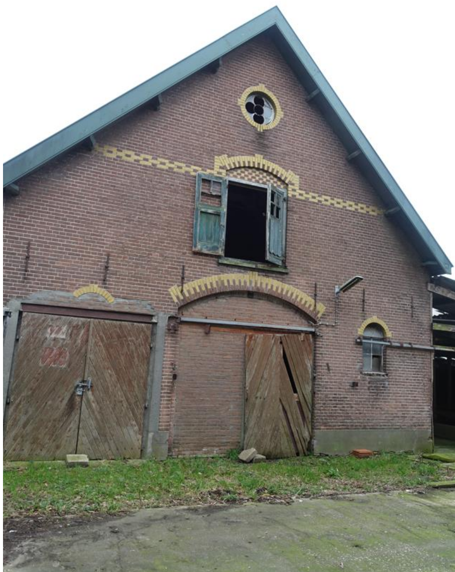
De aangepaste korte gevel richting de achterzijde van het bedrijfsgedeelte.
