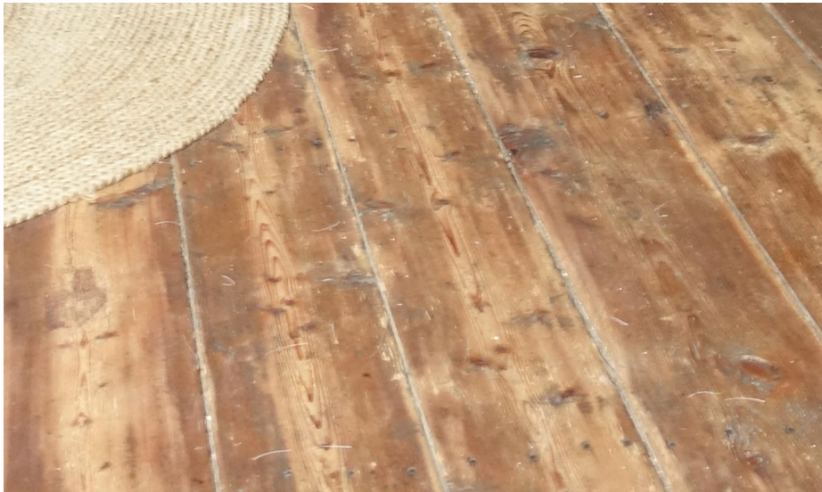
De zoldervloer van het woonhuis heeft vurenhouten vloerdelen, die mogelijk oorspronkelijk kunnen zijn.
