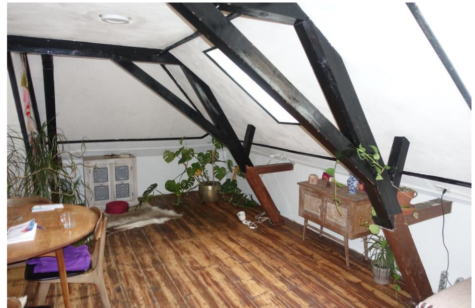
De onderste dekbalkjucken in de kap van het woonhuis.
