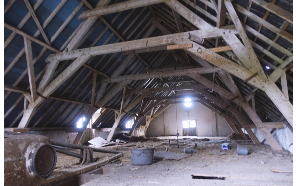
De ongedeelde zolder boven de korenschuur, gezien naar de achterzijde.
