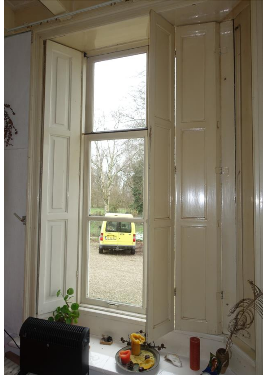
De raamluiken met ingelegde panelen bij een van de vensters op de begane grond van het woonhuis.
