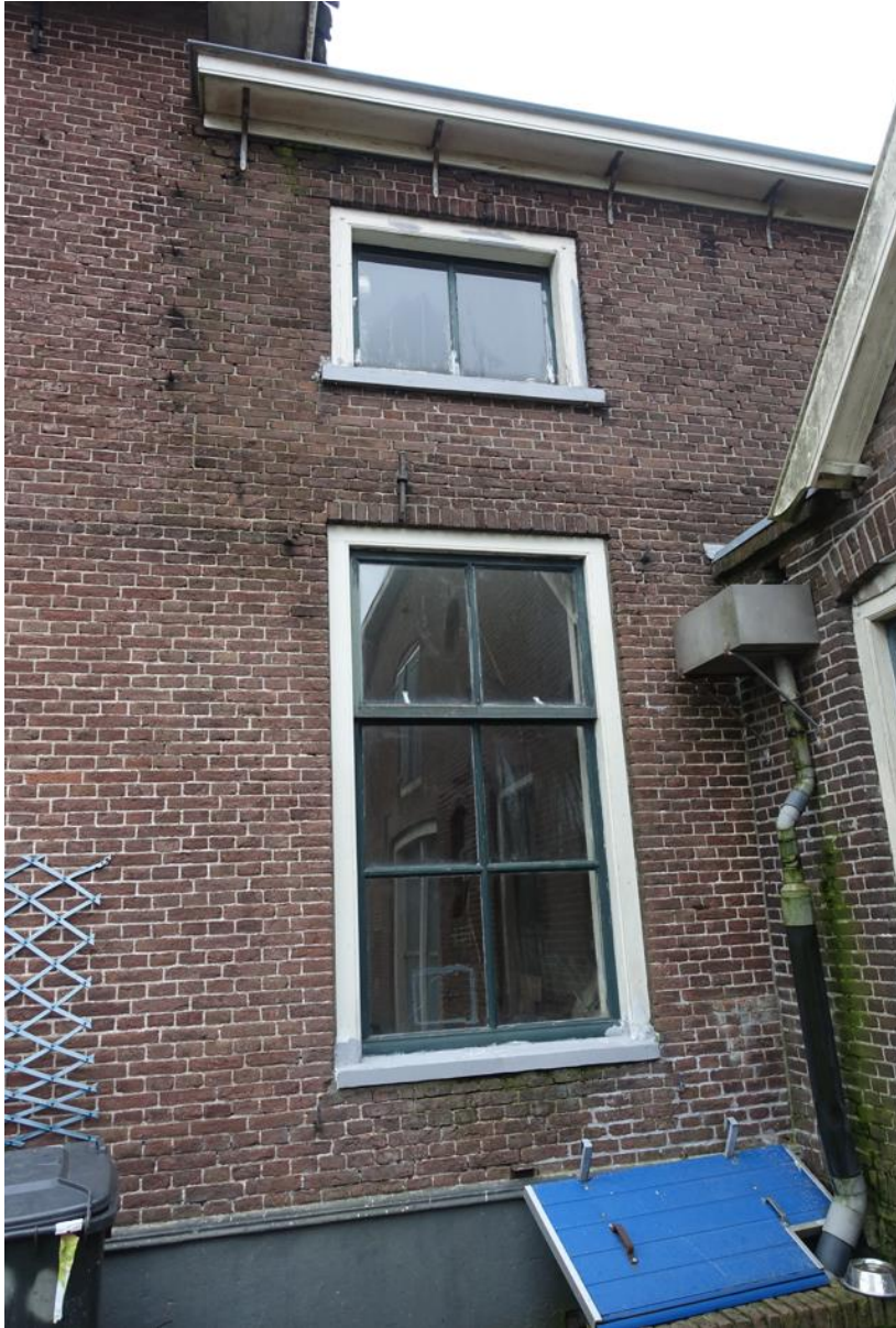
De opgehoogde zuidgevel van het krukhuis. Ook aan deze zijde is ter hoogte van de verdiepingvloer een overgang in het metselwerk te zien.
