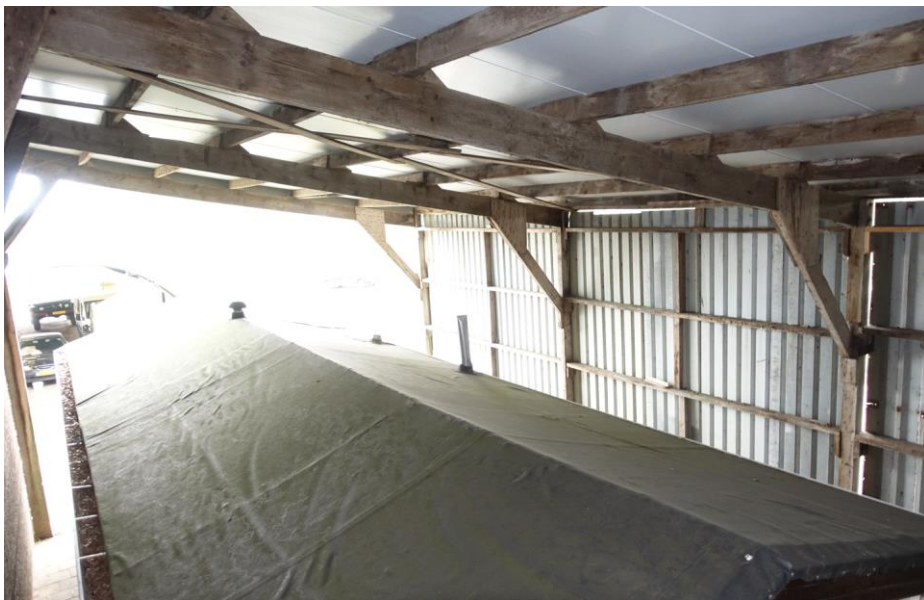
De kapconstructie van de overkapping ten zuiden van de jonge schuur.
