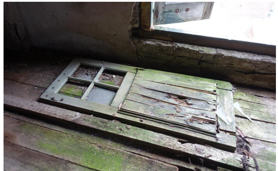
Een oorspronkelijk hooiluik op de zolder van de korenschuur.
