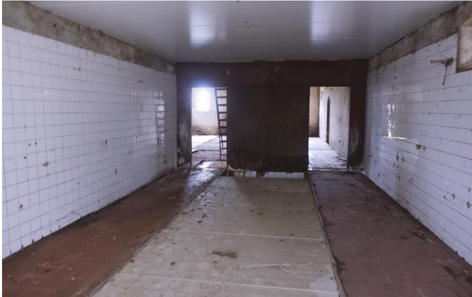
Een van de twee ruimtes op de begane grond aan de westzijde van de korenschuur.
