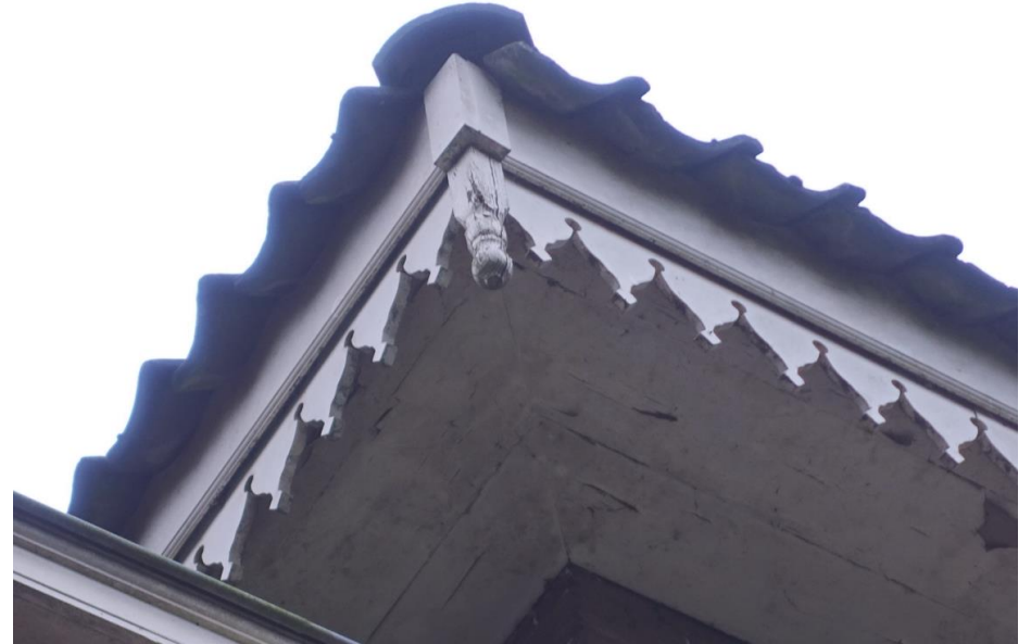
Detail van de druiplijst aan de onderzijde van het dak van het woonhuis.
