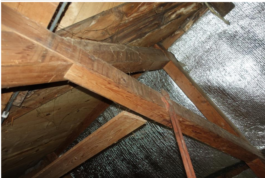
Zicht op de gestapelde A-spanten in de kap van het woonhuis.
