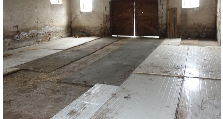
De begane grondvloer in de korenschuur.
