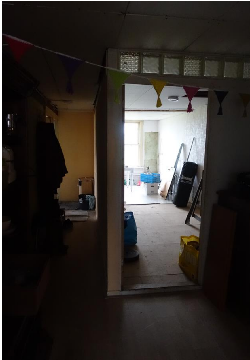
De gang op de verdieping van he woonhuis gezien richting de Achterstraat.
