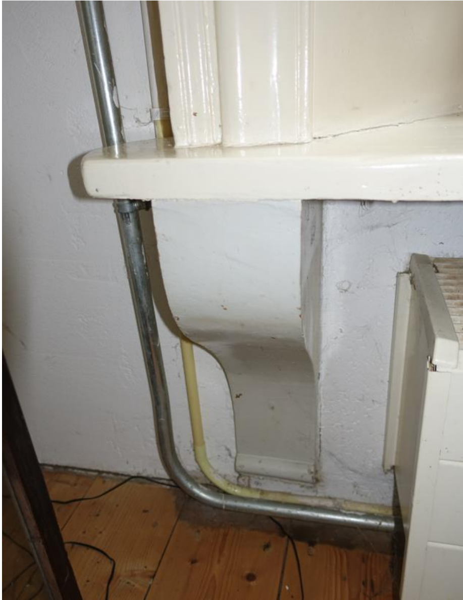
Detail van een oorspronkelijke console onder een vensterbank bij een van de vensters op de begane grond van het woonhuis.
