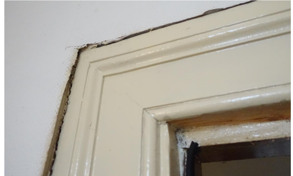
Detail van het binnenprofiel bij een deurpartij uit 1865.
