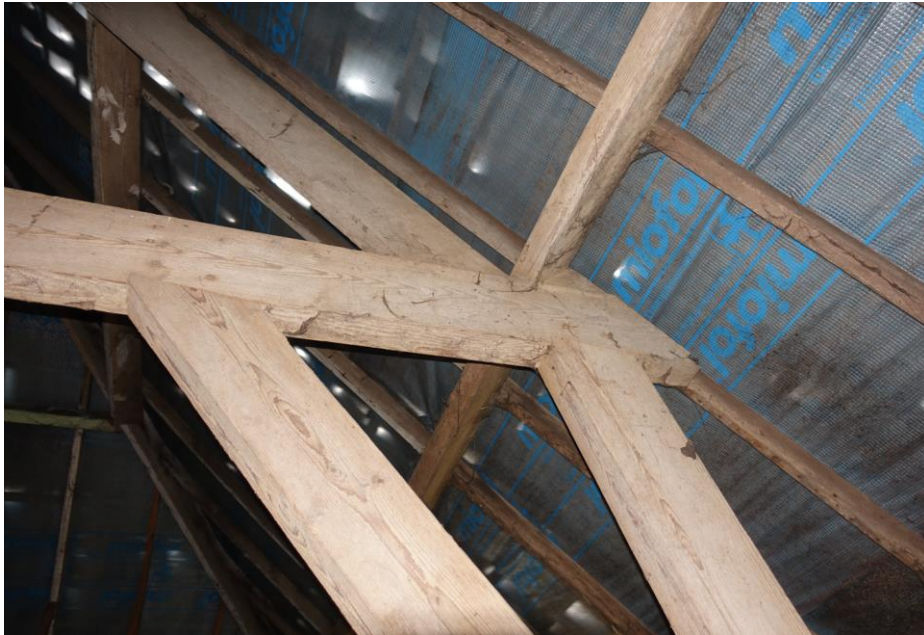
De meeste onderdelen van de kap zijn met elkaar verbonden via pen-gatverbindingen.
