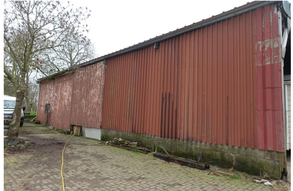
De overkapping ten zuiden van de jonge schuur bestaat uit damwandstalen gevels.
