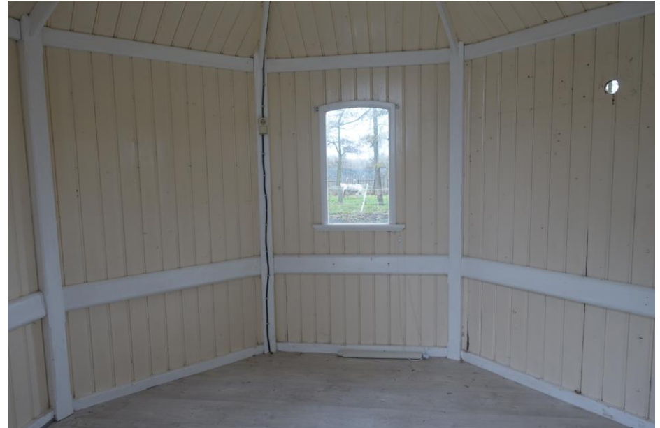
De vakwerkconstructie van het prieel.
