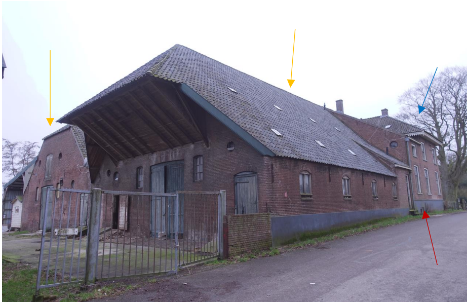
De twee schuren van het bedrijfsgedeelte (geel), het krukhuis (rood) en het woonhuis (blauw), gezien vanaf de Achterstraat.
