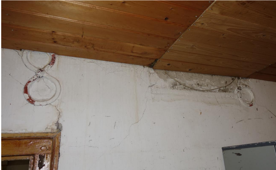
Op de verdieping van het krukhuis zijn oude muurankers in de achtergevel van het woonhuis opgenomen, zoals hier een cijfer 8 en 6.
