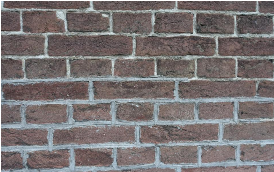
Detail van het metselwerk van het woonhuis met boven oud voegwerk en onder herstelt voegwerk.
