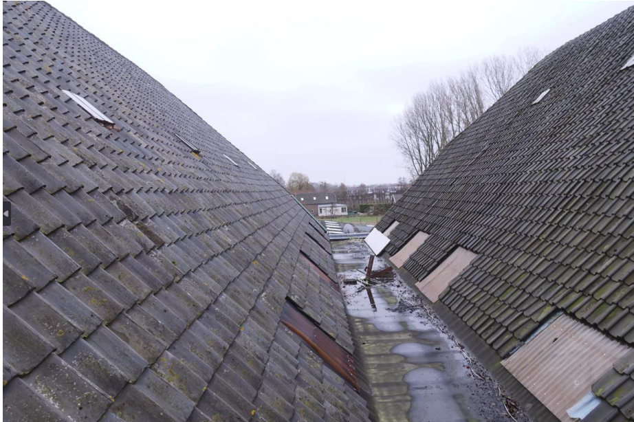
De zakgoot tussen de twee schuren van het bedrijfsgedeelte.
