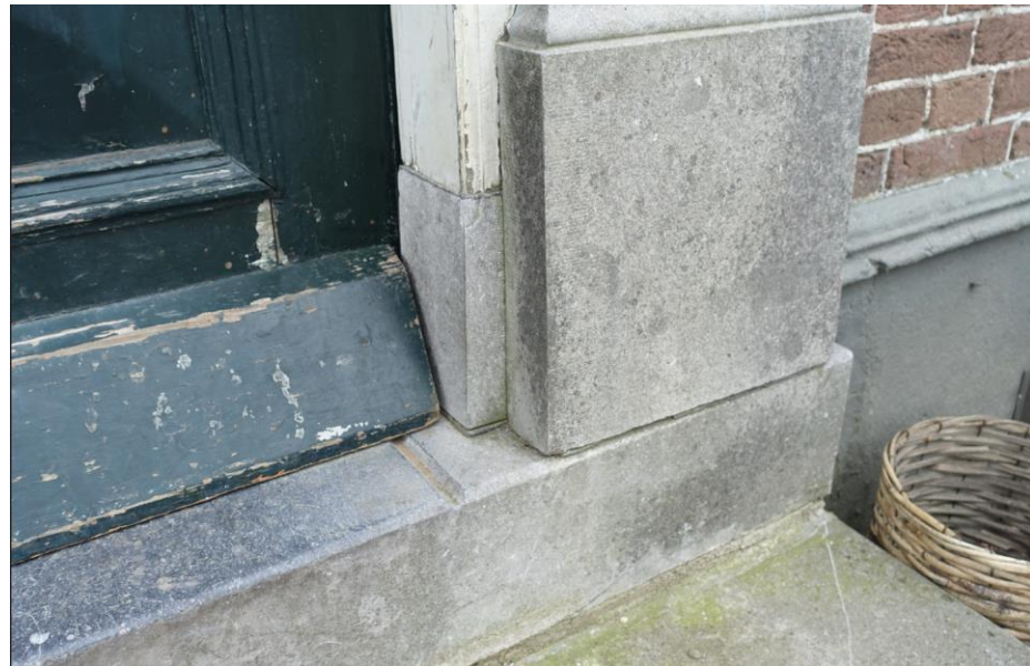
De hardstenen neuten en onderdorpel bij hoofdentree in de voorgevel van het woonhuis.
