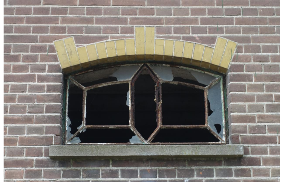
Een gietijzeren wieberraam.
