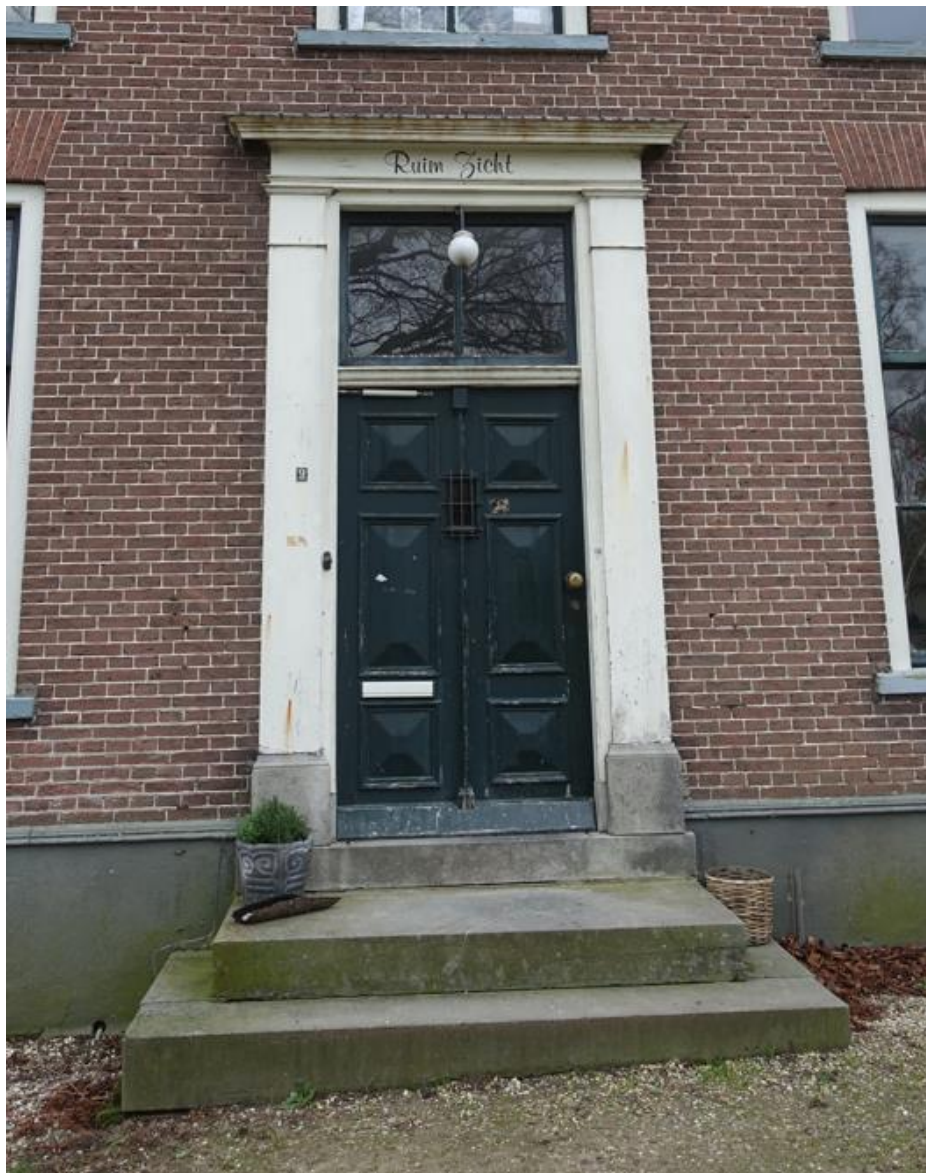
De hoofdentree in de voorgevel van het woonhuis heeft nog de oude opzet van een omlijste deurpartij met bovenlicht.
