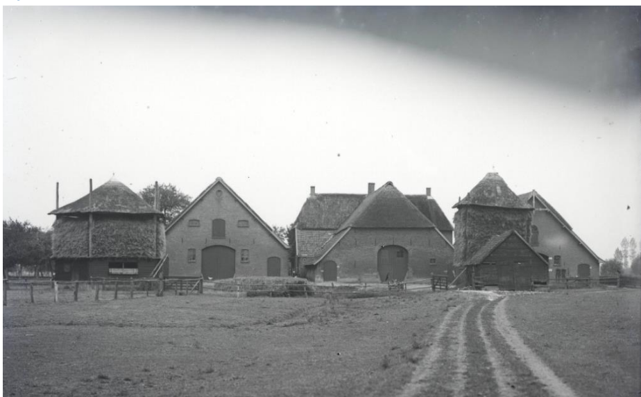
Een typisch Betuws boerderijensemble in Elst met een centrale oude T-boerderij waar later schuren en bergen zijn bijgebouwd. RCE beeldbank, nr. SHBO-F-KU075-3245.
