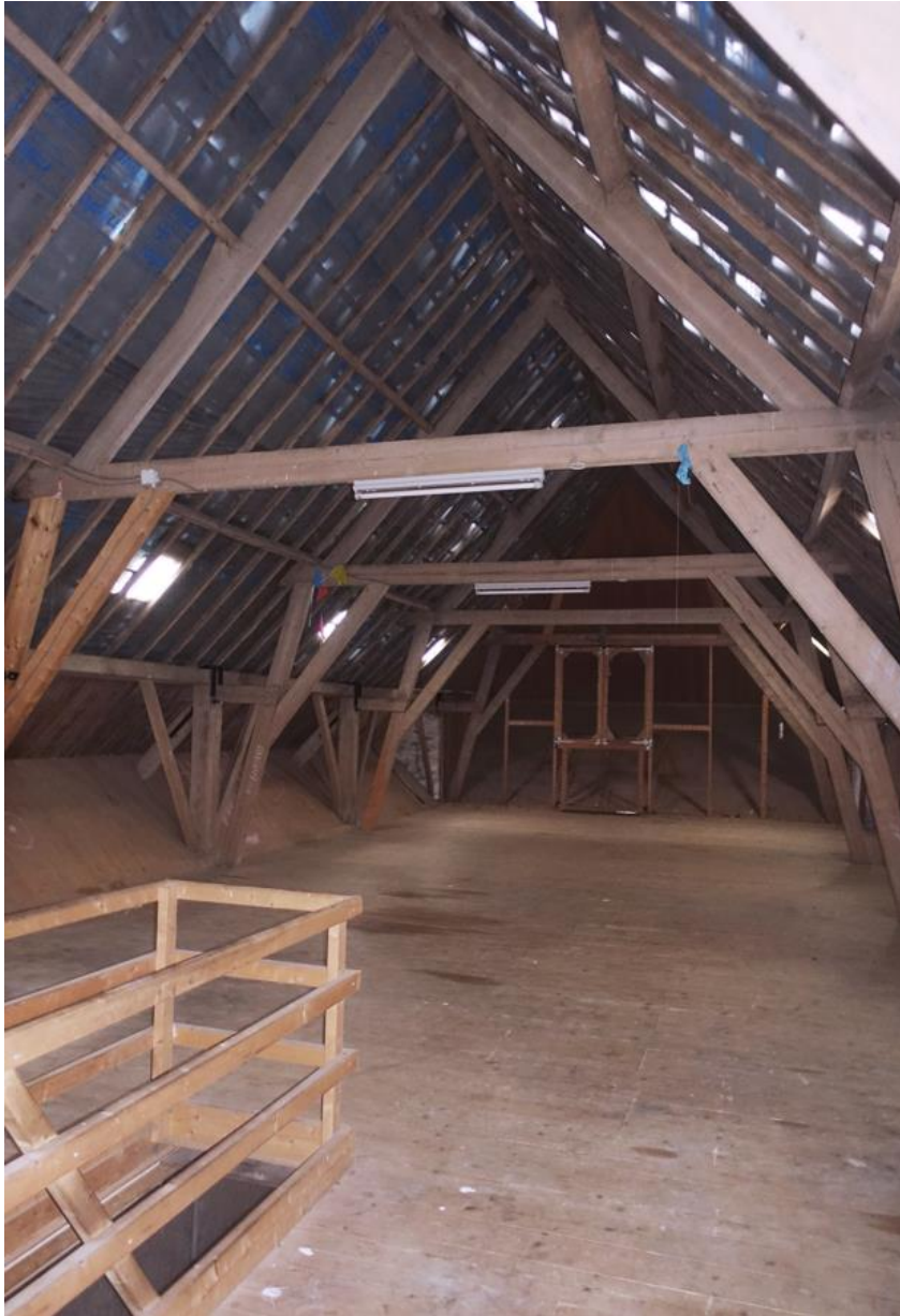
De zolder boven de oude schuur, gezien naar de achtergevel.
