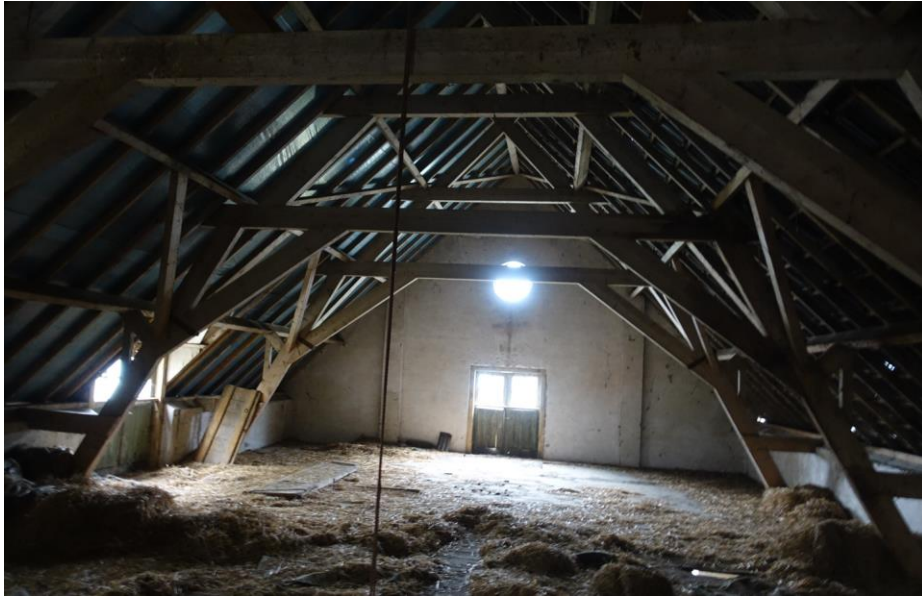
Dekbalkjucken vormen de onderste helft van de kapconstructie.
