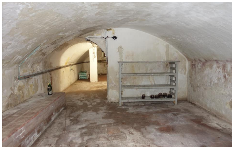
Het zuidelijke deel van de kelder met links de bakstenen ophoging.
