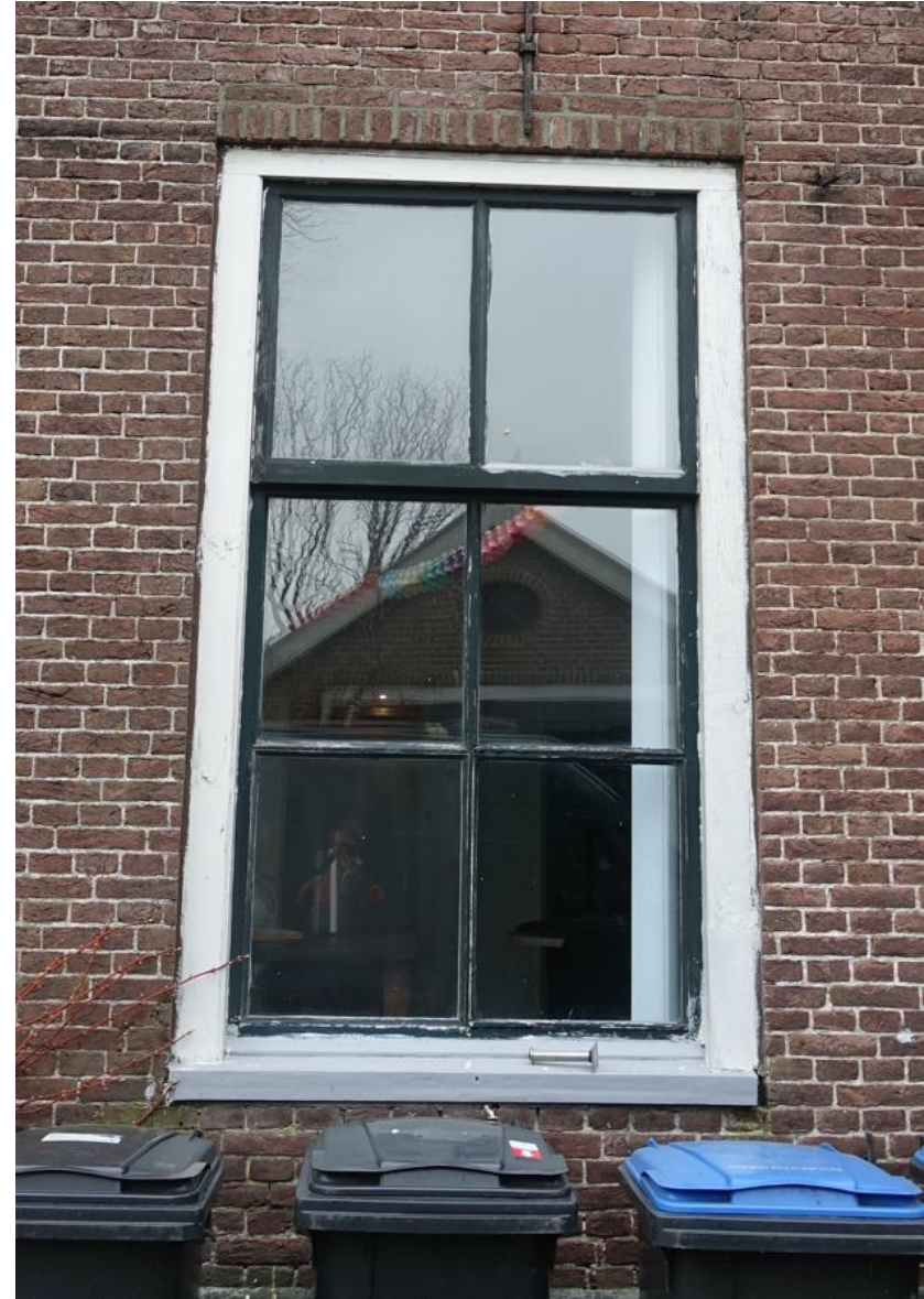
Het nieuwe venster in de zuidgevel van het woonhuis, te herkennen aan de ingeslepen dagkanten en de rollaag aan de bovenzijde.
