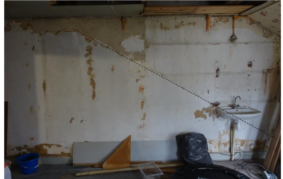
De achtergevel van het woonhuis gezien vanaf de kamer in het opgehoogde deel van het krukhuis aan de zijde van de Achterstraat. De diagonale stippellijn geeft de daklijn weer van voor de ophoging.
