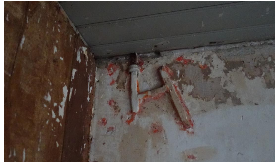
Op de verdieping van het krukhuis zijn oude muurankers in de achtergevel van het woonhuis opgenomen, zoals hier een cijfer 4.
