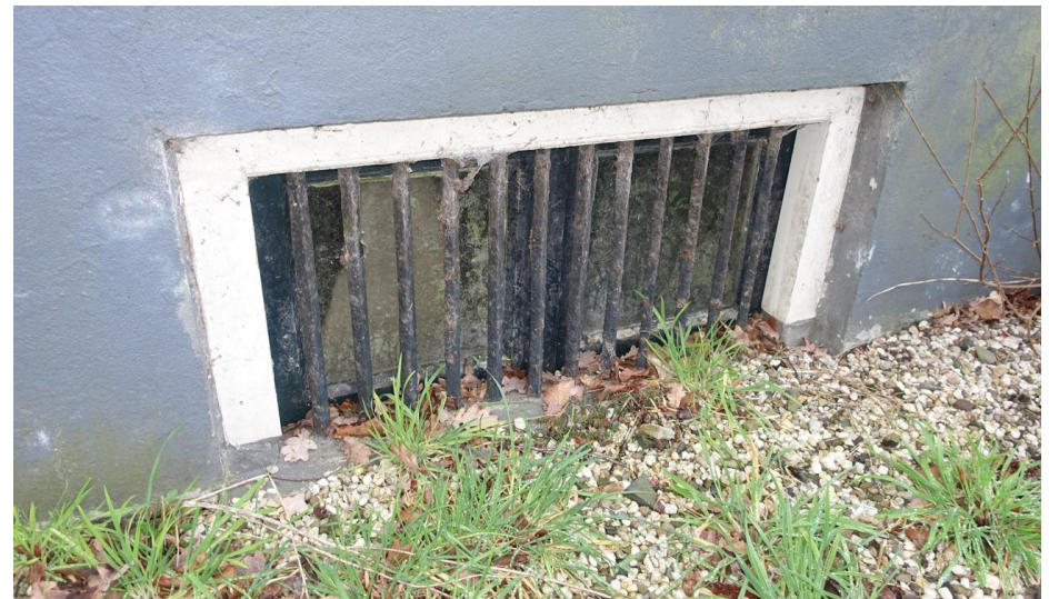
Het kelderlicht in de plint langs de Achterstraat.
