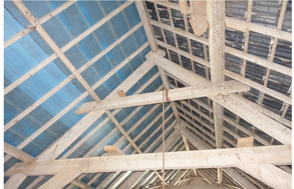
Een gestapeld A-spant in de kap van de korenschuur.
