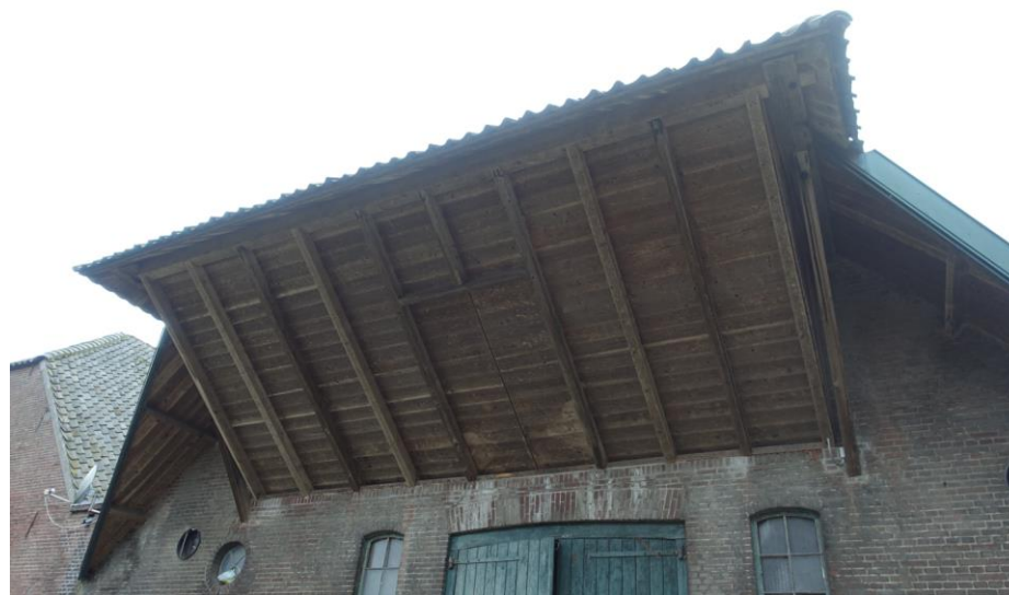
De achtergevel van de oude schuur wordt gekenmerkt door een overstek ter hoogte van de hooizolder.
