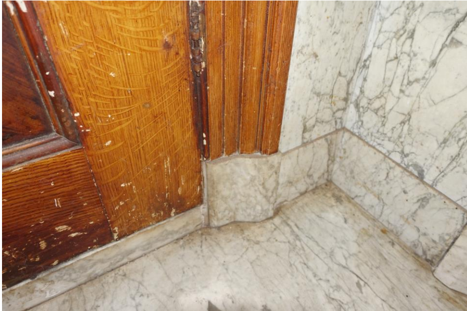
Detail van de houtimitatie bij een van de deurkozijnen in de gang van het woonhuis.
