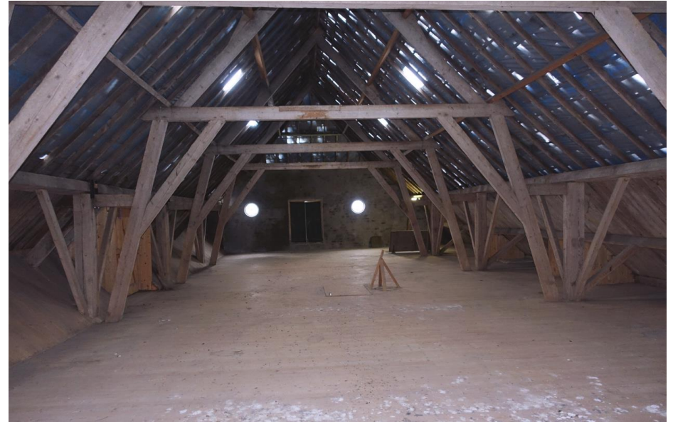
De zolder boven de jonge schuur van het bedrijfsgedeelte, gezien richting de voorzijde.
