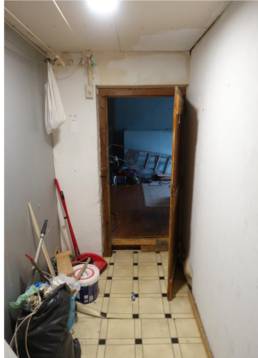
De zolder in het woonhuis gezien richting de overloop in het krukhuis.
