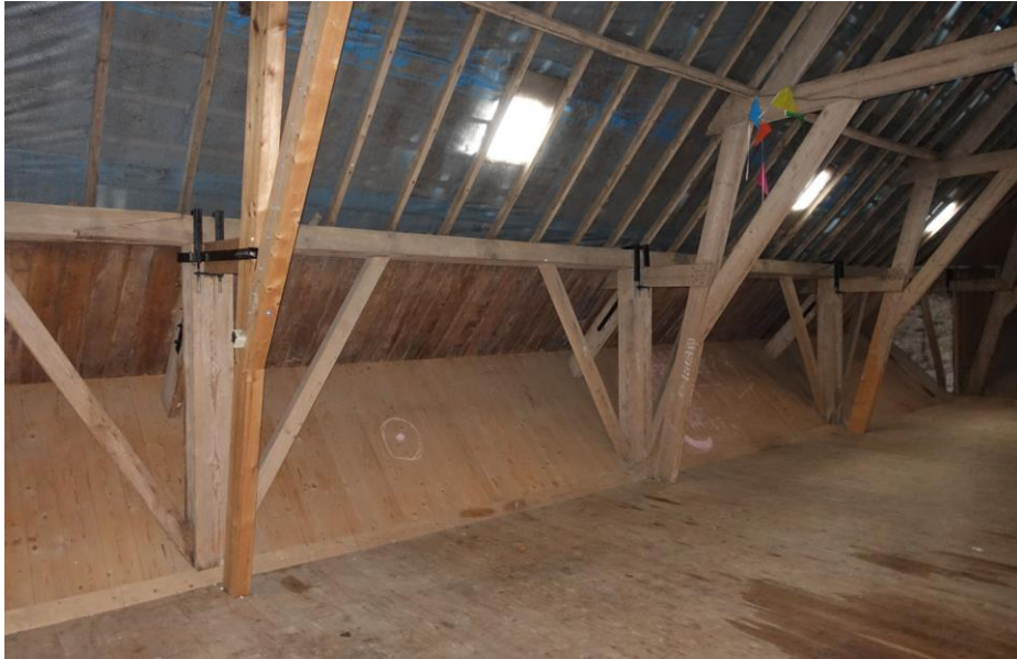
De gebintstijlen ter hoogte van de zolder boven de oude schuur.
