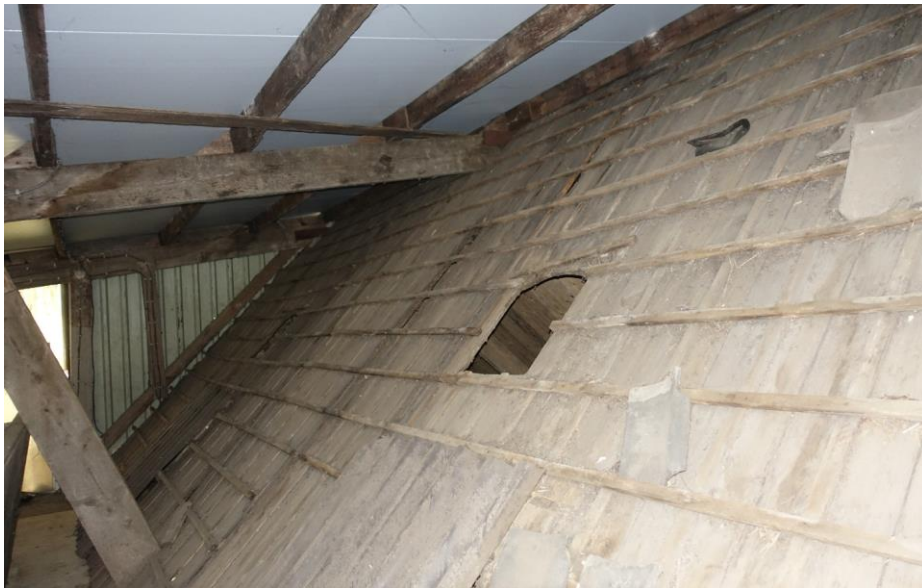
Het dakvlak van de jonge schuur bij de aansluiting van de moderne overkapping.
