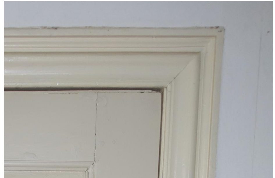
Het ojevormige binnenprofiel van het kozijn tussen de gang en de voorkamer rechts.
