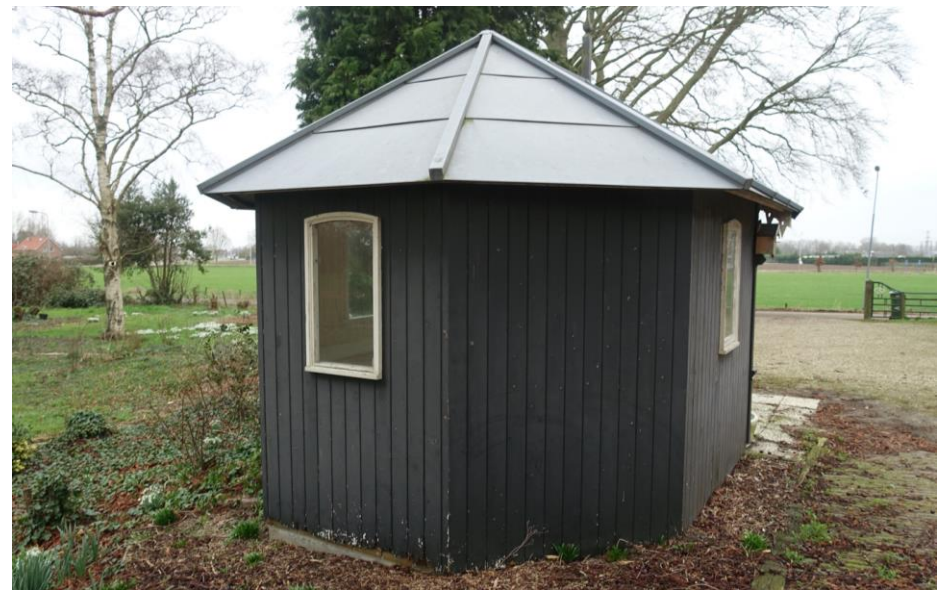
De houten schroten aan de buitenzijde van het prieel lijken vernieuwd te zijn.
