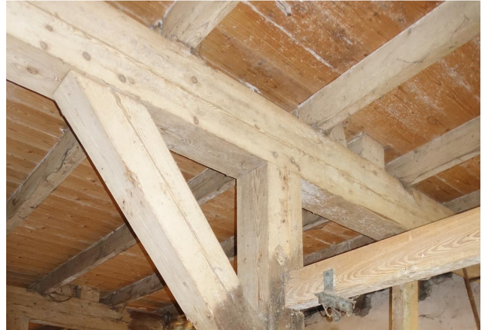
De zolderbalklaag in de jonge schuur.
