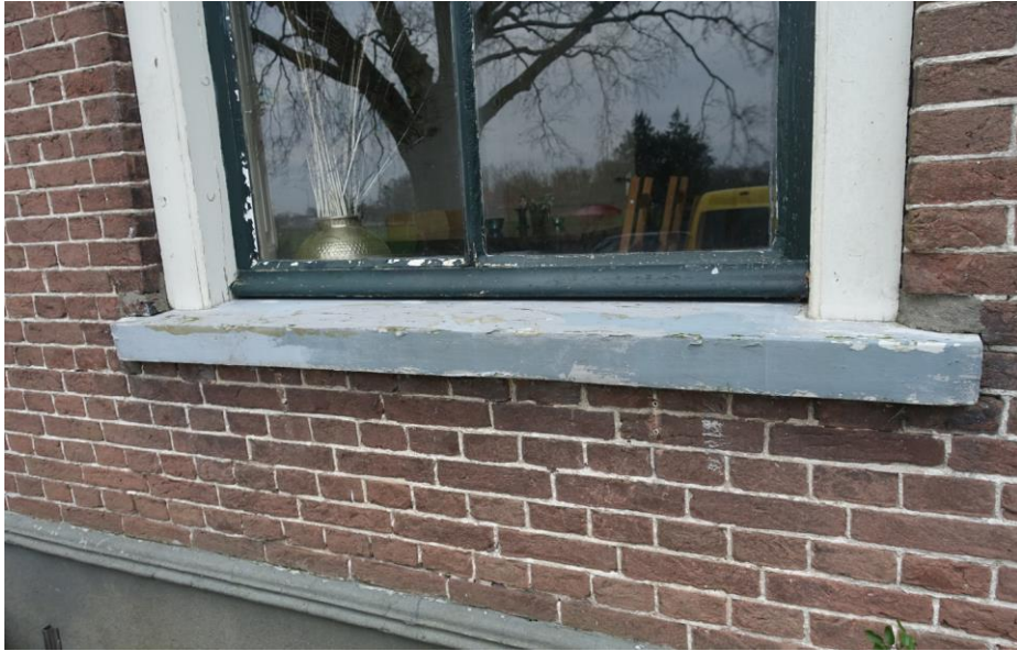
Detail van een venster in de voorgevel van het woonhuis met houten lekdoprel en raamkozijn met kraalprofiel.
