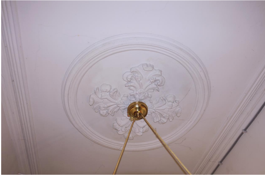
Het stucplafond boven de middengang op de begane grond van het woonhuis.
