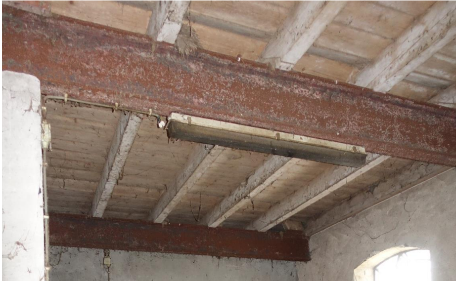
De constructie van de zoldervloer in de korenschuur is nog oorspronkelijk.
