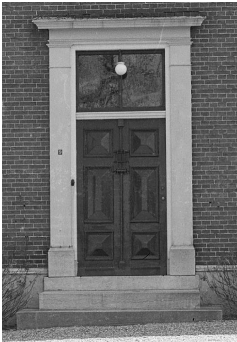
Detail van de hoofdentree op de foto uit 1966. RCE beeldbank, nr. 103.150.
