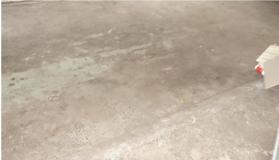
De betonnen begane grond vloer in de oude schuur.
