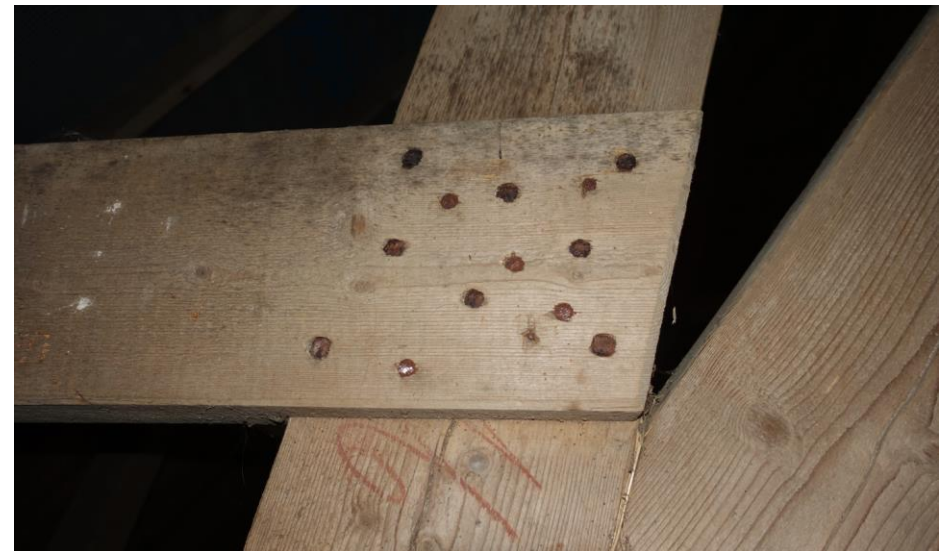
Een genagelde verbinding tussen blokkeel en spantbeen.
