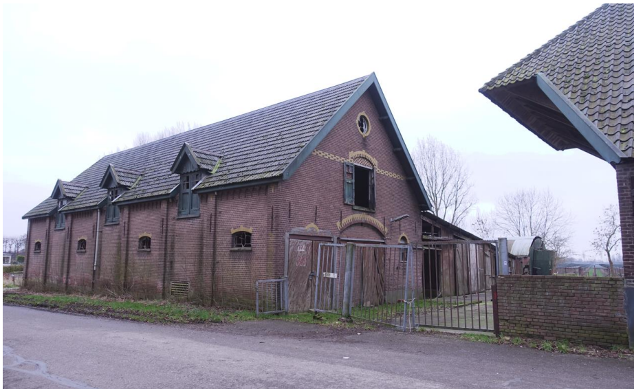
De voormalige korenschuur ligt met zijgevel aan de Achterstraat.
