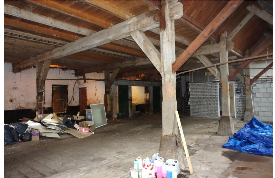
De gebinten in de oude schuur.
