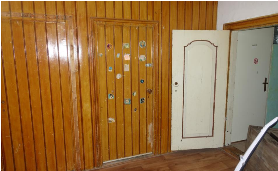
An de overloop waren van oorsprong links en rechts twee kamers gelegen die in de huidige situatie zijn samengevoegd.
