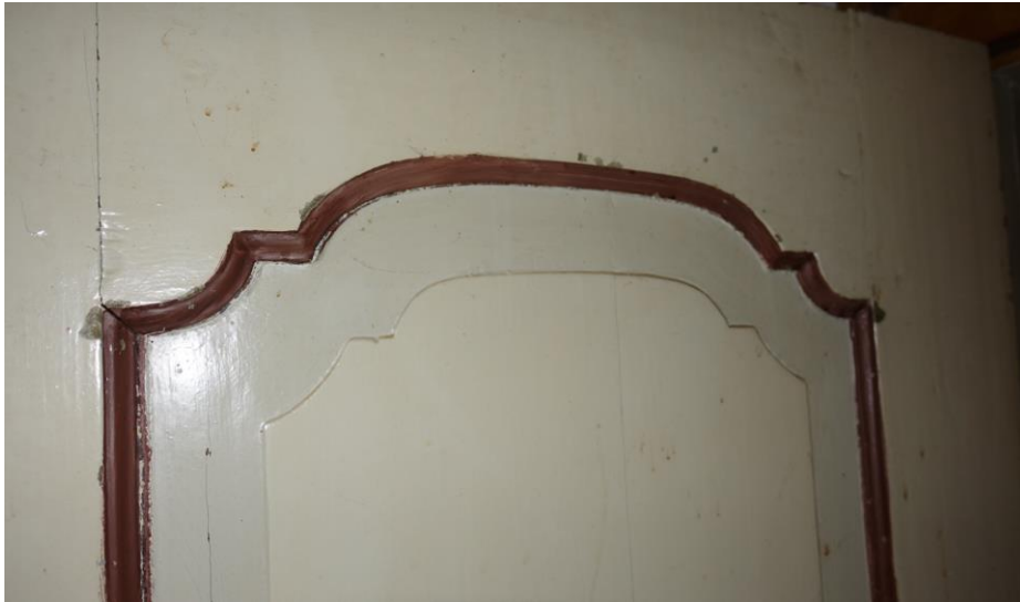
De doorgang tussen de overloop in het krukhuis en de verdieping van het woonhuis is ingezet met een 18 de -eeuws kozijn en bijbehorende paneeldeur.
