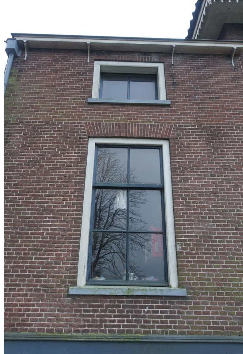
De opgehoogde gevel van het krukhuis aan de zijde van de Achterstraat. Ter hoogte van de verdiepingsvloer is een overgang in het metselwerk te zien.
