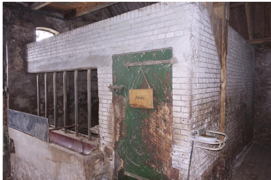
Een stalindeling aan de achterzijde van de jonge schuur, opgemetseld met kalkzandsteen.
