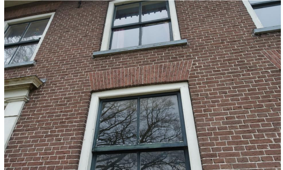
Detail van de gemetselde strek boven een gevelopening aan de voorzijde van het woonhuis.
