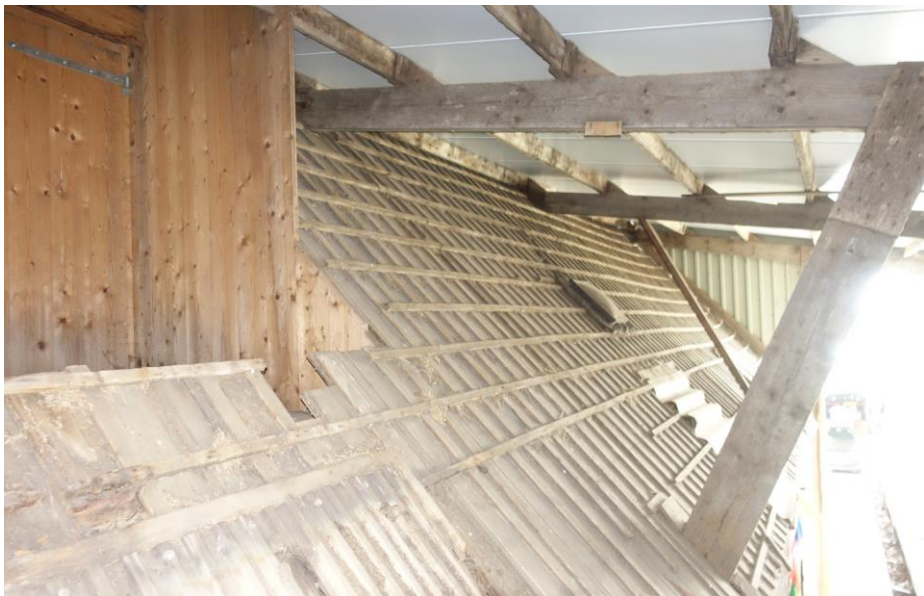
De kapconstructie van de overkapping bij de aansluiting op jonge schuur.
