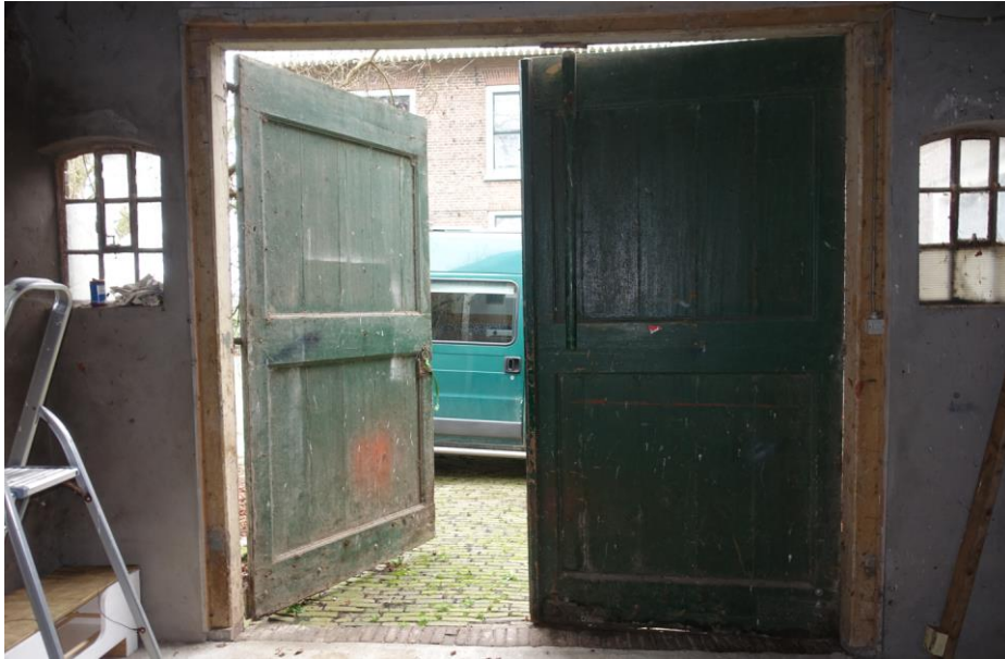
De dubbele deuren en de twee 9-ruits ramen in de gevel van het koetshuis die naar het woonhuis wijst.
