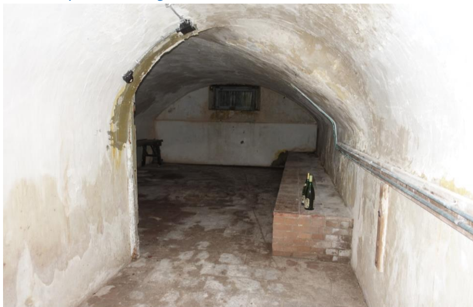
Het zuidelijke deel van de kelder.
