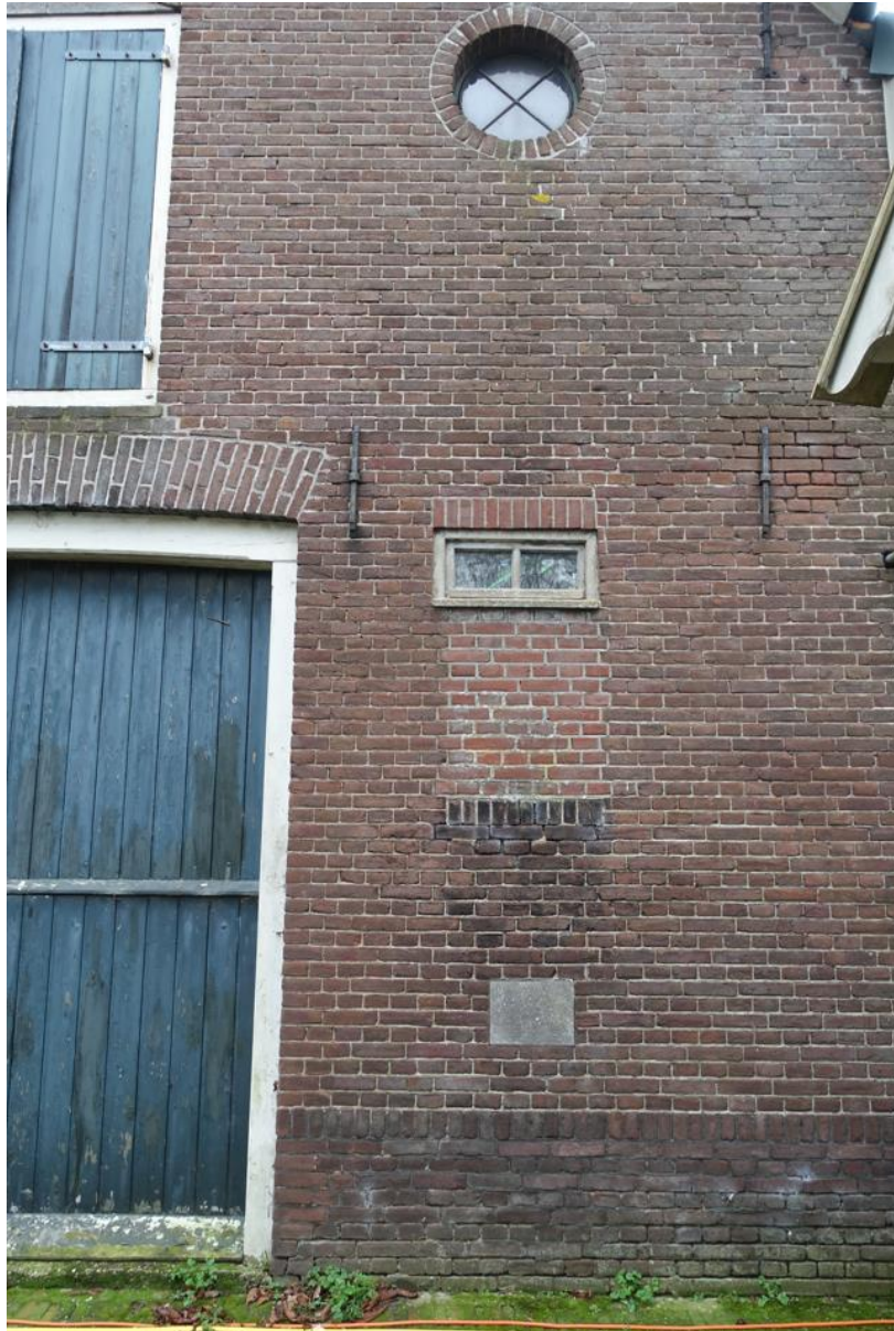
De voorzijde van de jonge schuur met bij de rode omlijning de gevelsteen van de eerstesteenlegging.
