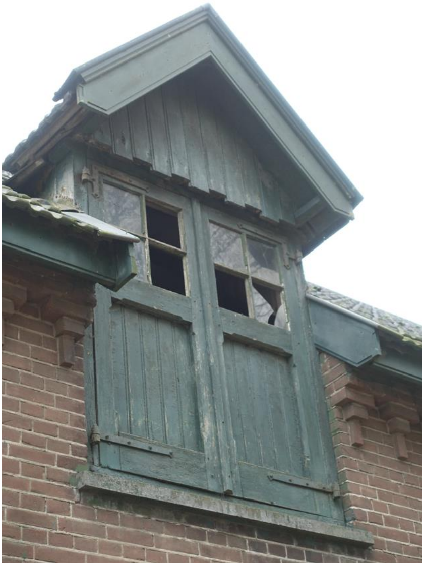
Een van de dakkapellen aan de bovenzijde van de langsgevel aan de Achterstraat.
