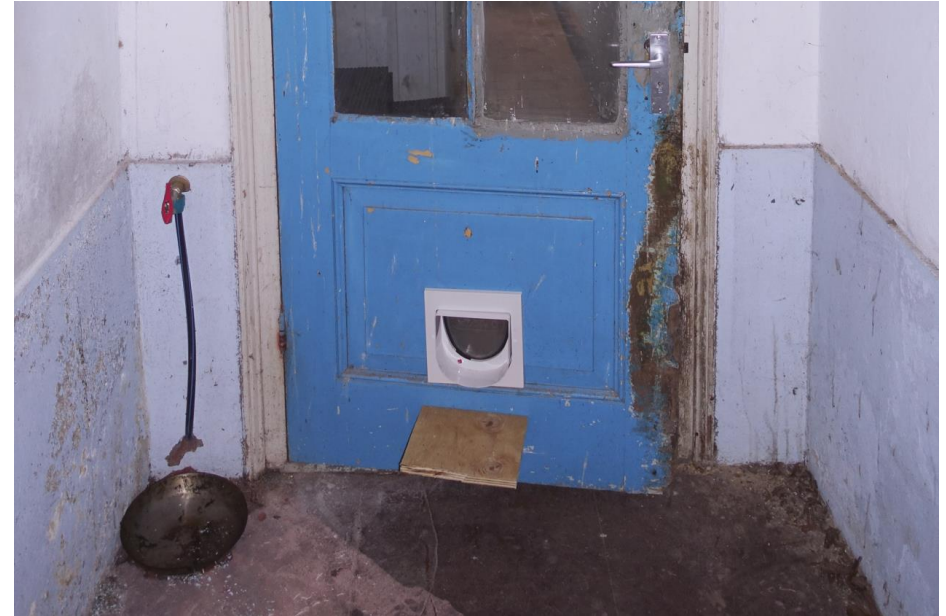
In de gang op de begane grond van het bedrijfsgebouwe is een lambrisering van beton of cementsmeersel.
