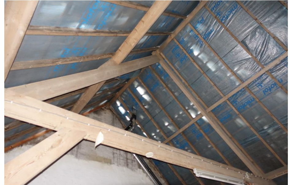
Zicht op een gestapeld A-spant. De daksporen lijken tot de oorspronkelijke opzet van 1903 te horen. Het dakfolie is recent aangebracht.
