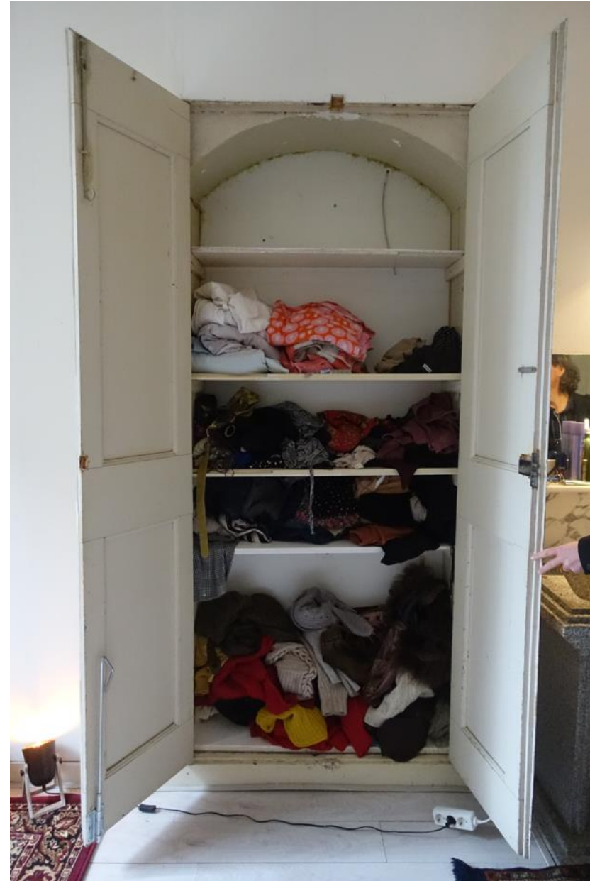
De voormalige doorgang tussen de rechter voor- en achterkamer.
