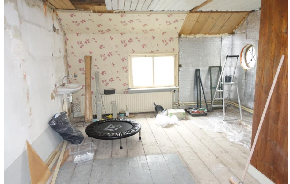
De kamer op de verdieping van het krukhuis gericht op de Achterstraat.
