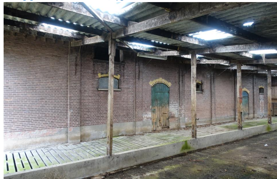
Tegen de zuidelijke langsgevel van de korenschuur is een overkapping gemaakt.
