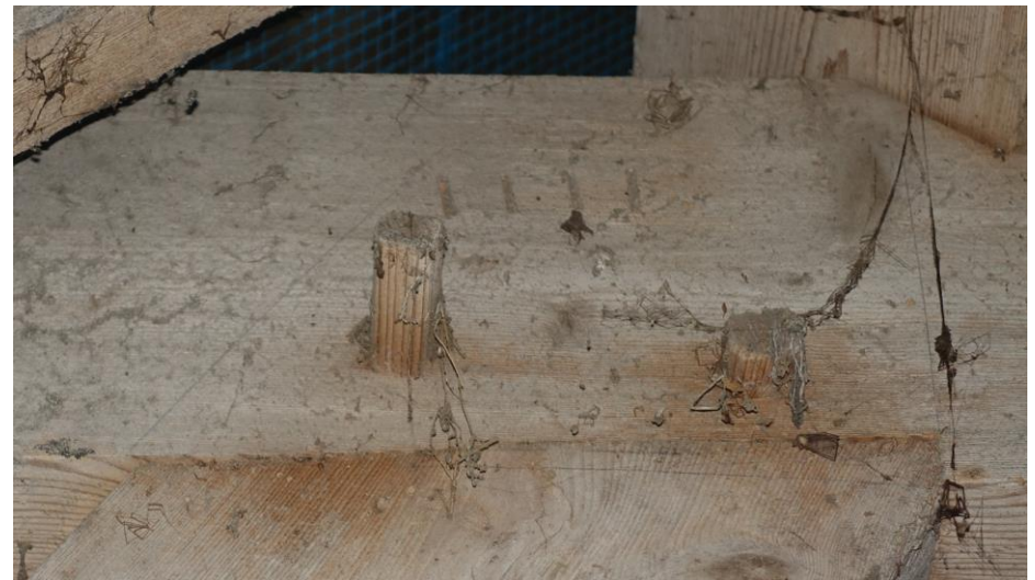
Detail van een gehakt telmerk IIII en potloodstrep ter plaatse van het pengat waarmee het spantbeen in de dekbalk is bevestigd.
