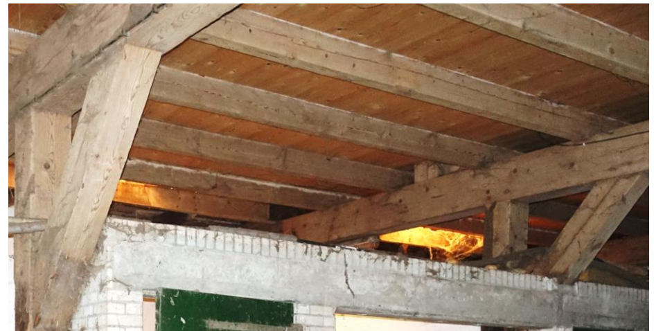
De zolderbalklaag in de oude schuur.
