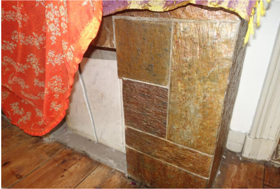
De leiste schouwmantel in de voorkamer links aan de gang is van na 1950.
