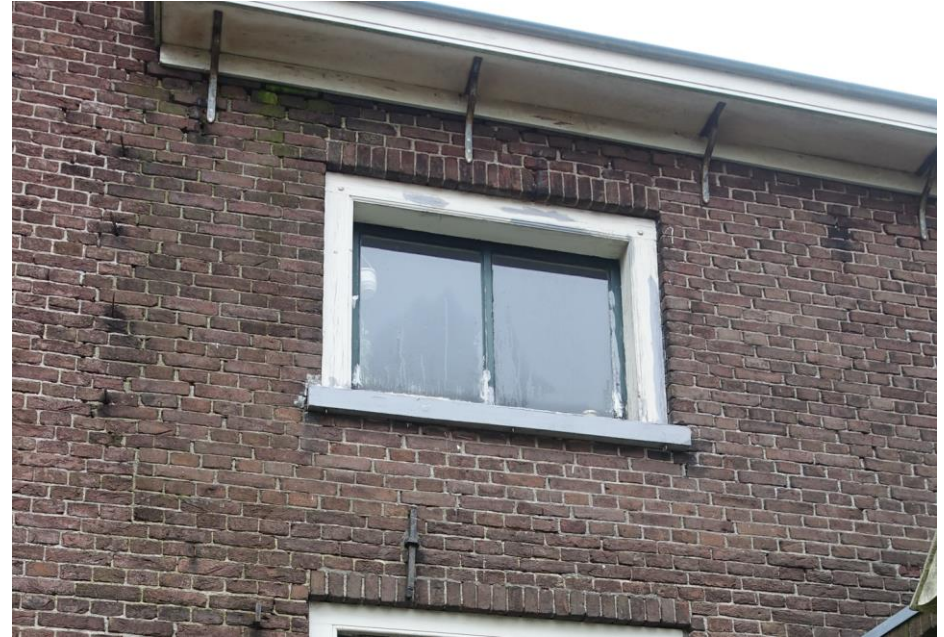
De vensters op de verdieping van het krukhuis zijn aangebracht toen de verdieping werd toegevoegd.
