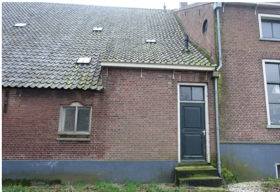
Het opgehoogde deel van de lange zijgevel aan de Achterstraat behoort tot een jongere fase. Ook de betonnen stalramen zijn van een veel jongere bouwphase.
