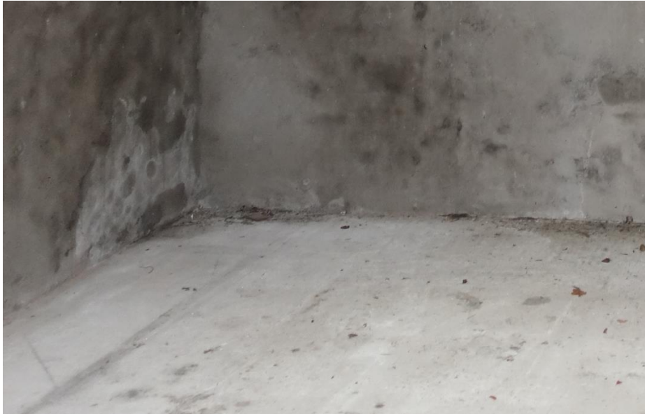
De betonnen vloer in het koetshuis.
