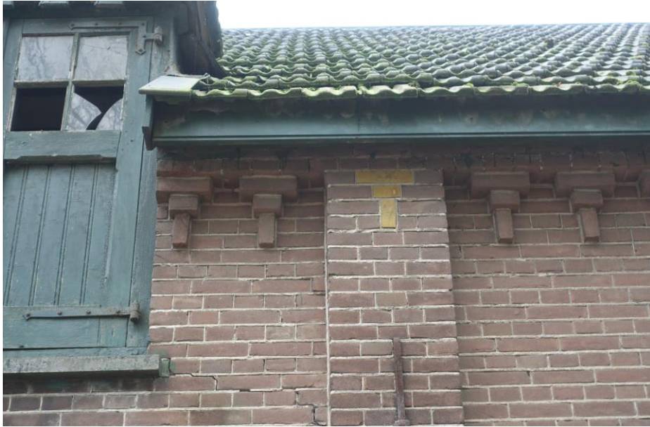
Detail van het boogfries aan de bovenzijde van de langsgevel met traveeën aan de Achterstraat.
