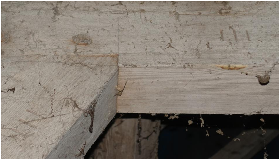
Detail van het gehakte telmerk III.
