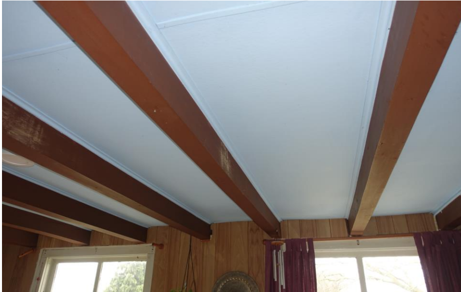
De zolderbalklaag in het woonhuis is nog oorspronkelijk.
