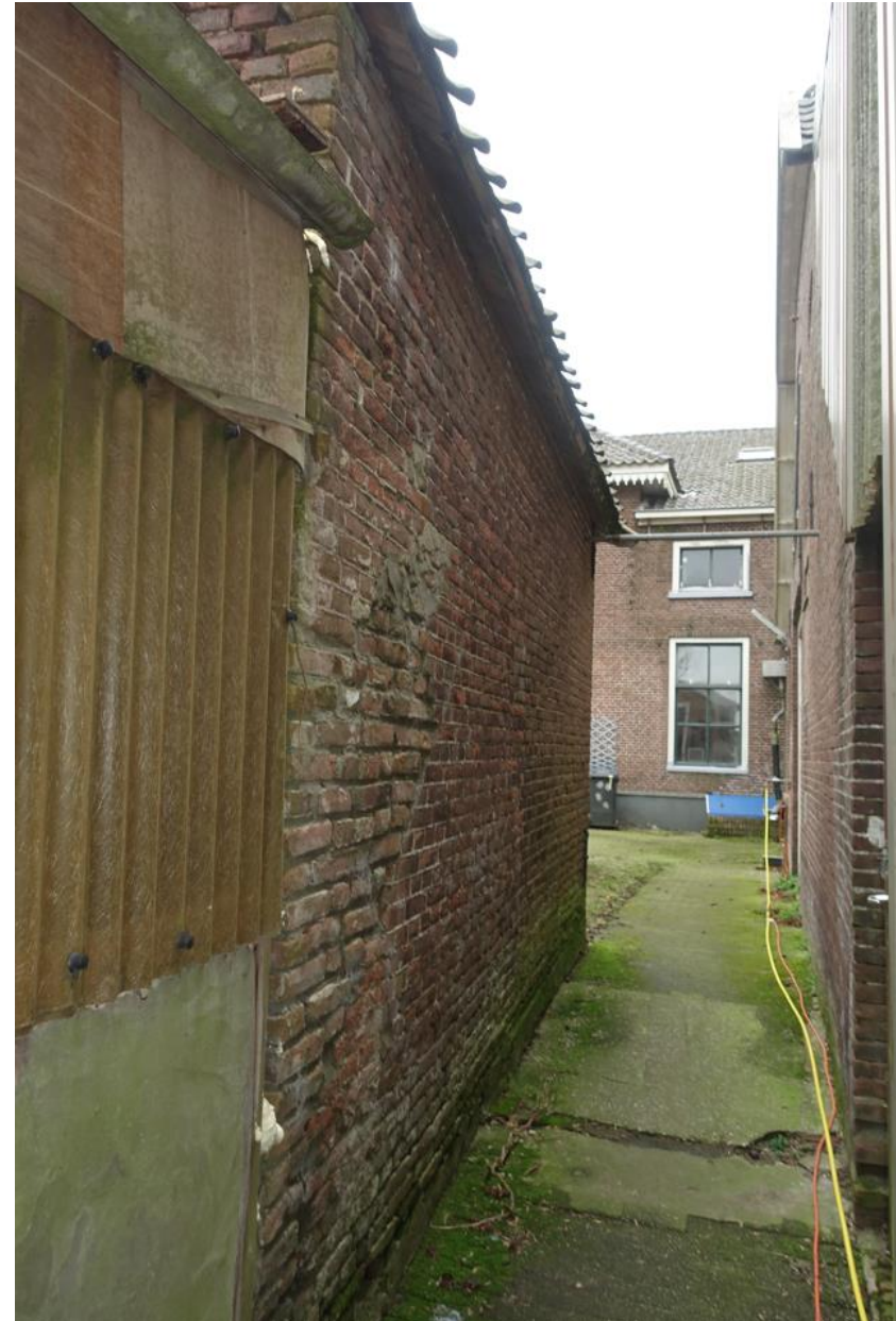
Het ingeboete metselwerk van het koesthuis ter plaatse van de oorspronkelijke uitbouw.
