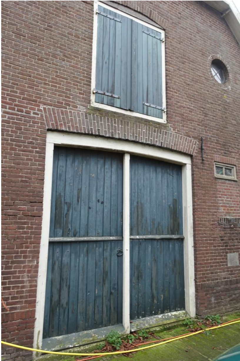
De hoge deeldeuren en het dubbele hooiluik aan de voorzijde van de jonge schuur.
