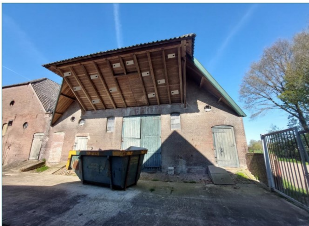
Figuur 6: Globale locaties van de permanente gierzwaluwvoorzieningen in de huif van de achterschuur. Er worden 20 kasten achter de huif geplaatst. Vanaf de buitenzijde zijn enkel de invliegopeningen zichtbaar.
