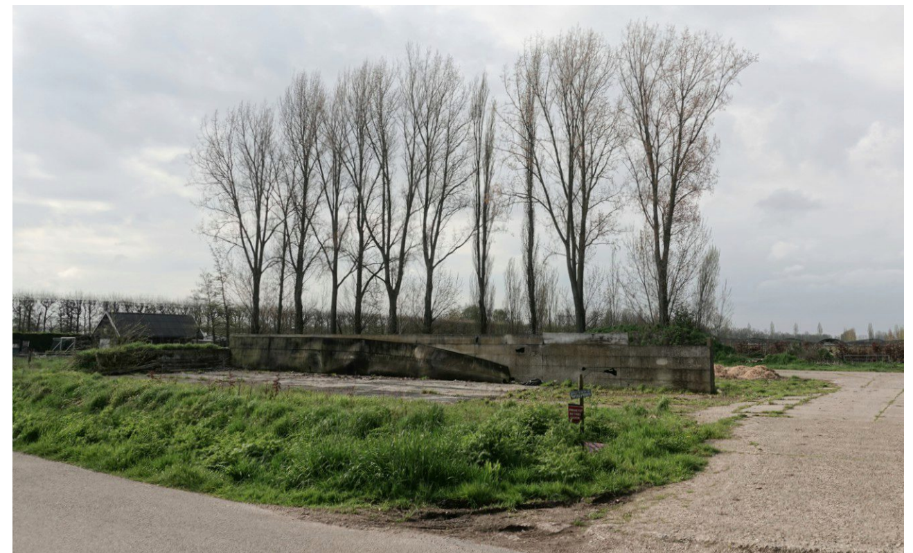
Oostzijde terrein met betonplaten van de voormalige voeropslag (kuilvoer) en een rij populieren
