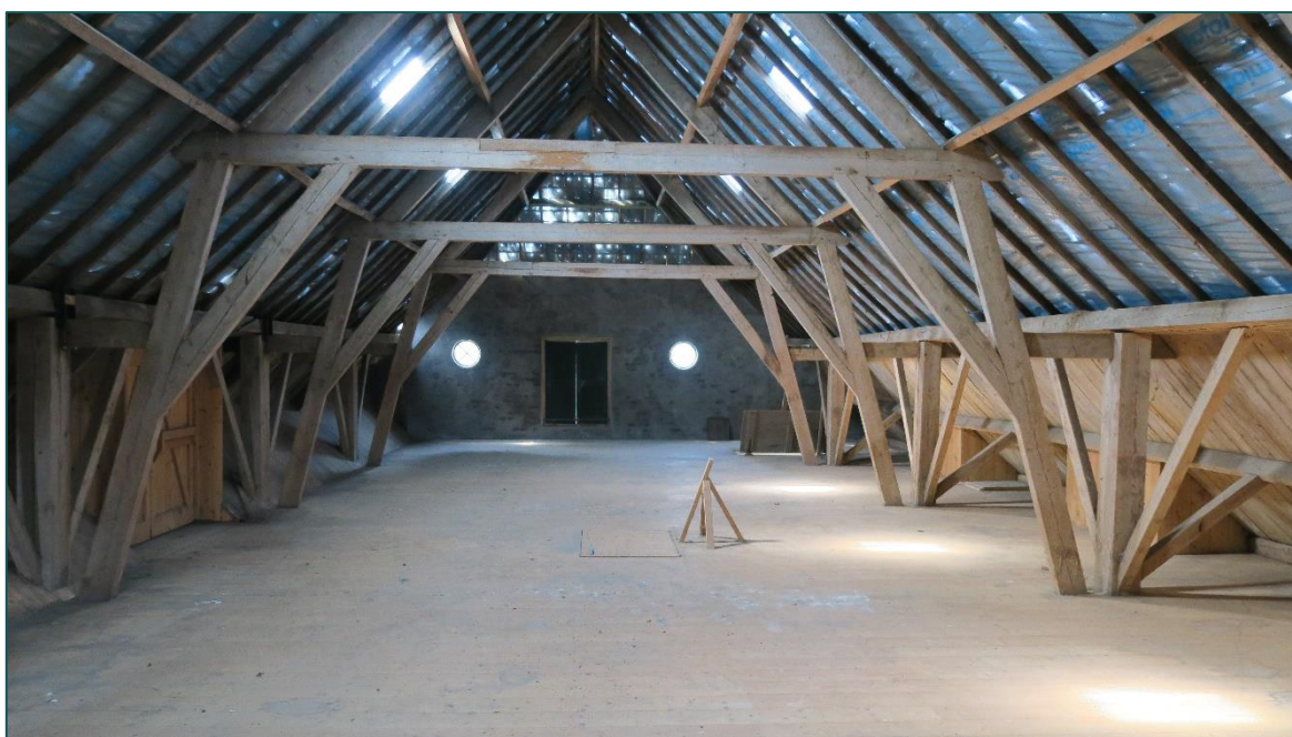
Figuur 2 Binnenzijde van de bijschuur.
