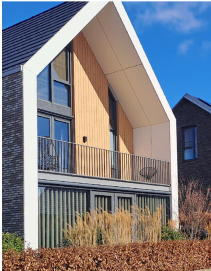
uitgesproken geveloriëntatie op groenzones (loggia)
