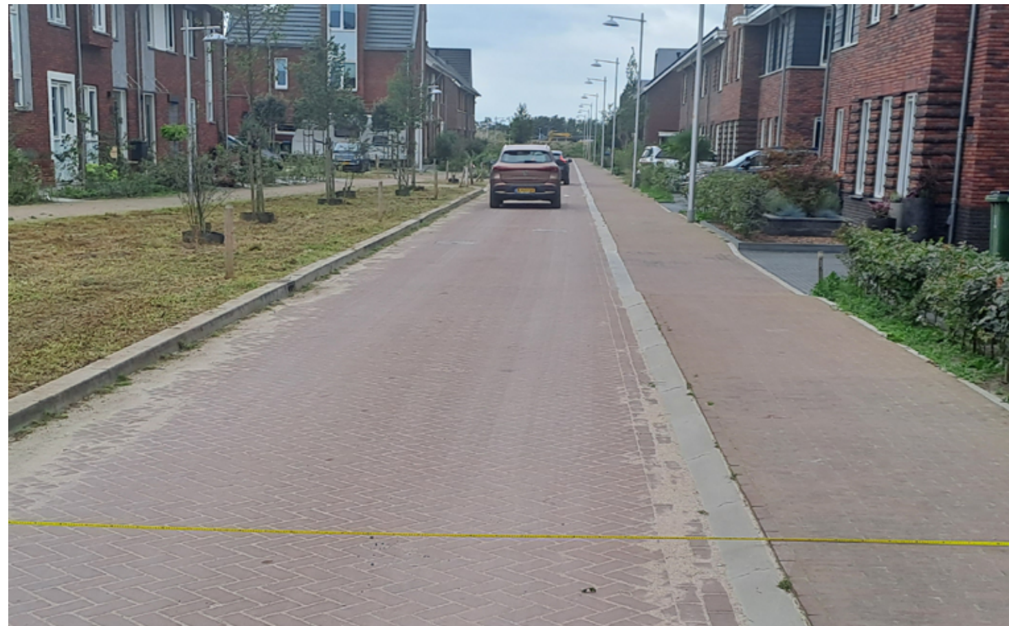
referentiebeeld van dezelfde straat te Ede. De schuine geleideband rechts maakt ook uitwijken voor fietsers mogelijk. De hoge trottoirband links voorkomt langsparkeren in de berm.
