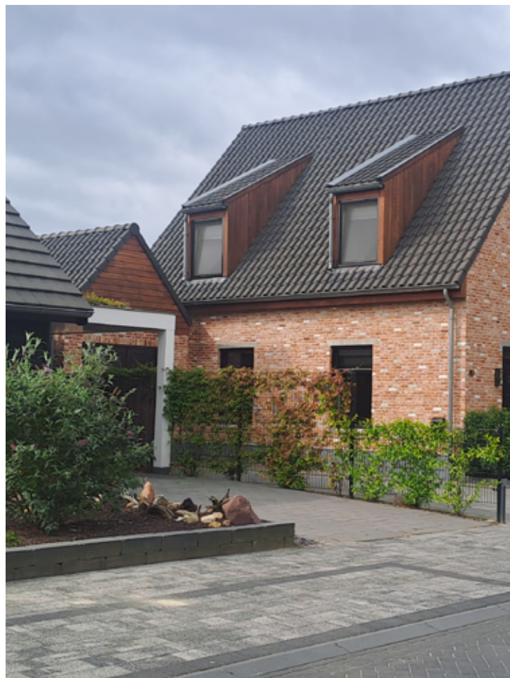
garage in lijn met de woning
