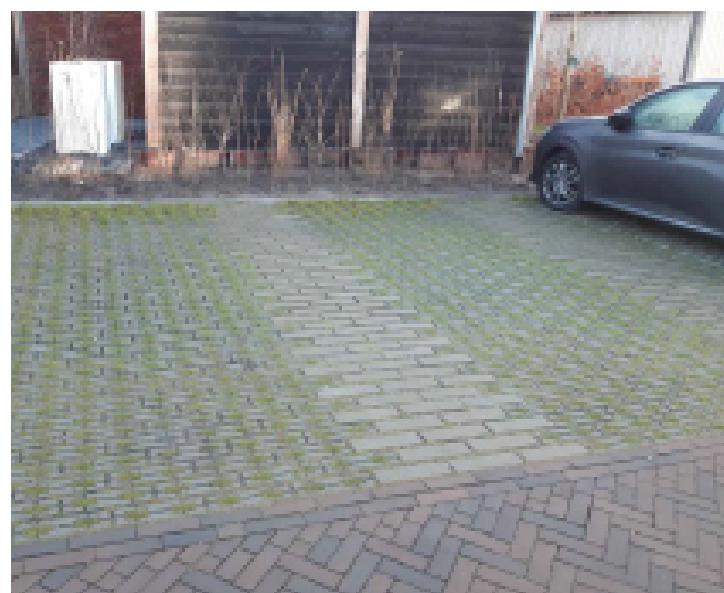
Parkeren op open grasbetonklinkers NCB.: waterdoorlatend, minder hittestress, vriendelijk ogend.
