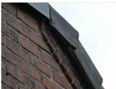
Figuur 5.10 Verblijfplaats van vleermuis bij overhangende kantpannen.
