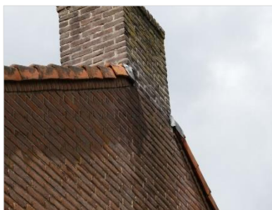
Figuur 5.9 Verblijfplaats van vleermuis bij overhangende kantpannen en loodslabben.
