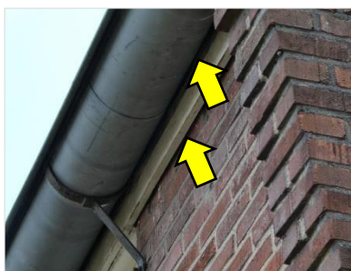
Figuur 4.17 Ruimte achter dakgoot en achter betimmering.
