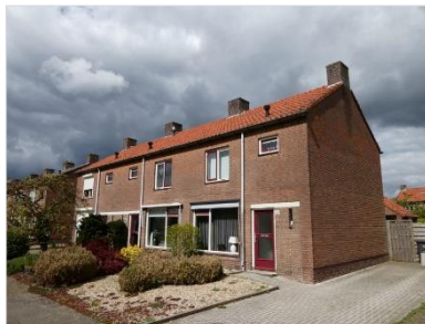
Figuur 2.17 Bebouwing aan de Wethouder Sandersstraat (40-50).
