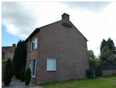
Figuur 2.6 Bebouwing aan de Rozenstraat (23 en 25).
