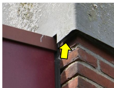
Figuur 4.19 Ruimte bij schoorsteenkap.
