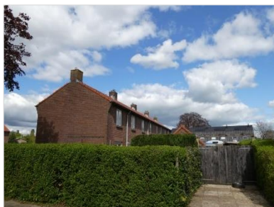
Figuur 2.12 Bebouwing aan de Enkweg (13-19).
