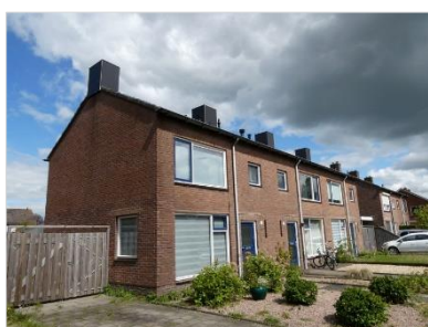
Figuur 2.29 Bebouwing aan de Wethouder Sandersstraat (64-72).
