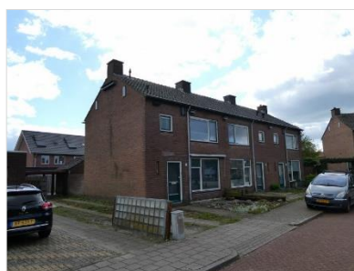
Figuur 2.3 Bebouwing aan de Rozenstraat (17-21).
