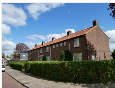
Figuur 2.11 Bebouwing aan de Enkweg (13-19).
