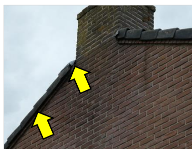
Figuur 4.16 Ruimte bij kantpannen en loodslabben.
