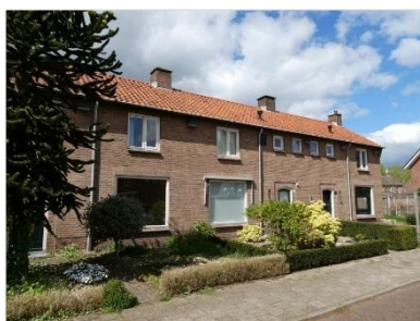
Figuur 2.9 Bebouwing aan de Enkweg (26-30).
