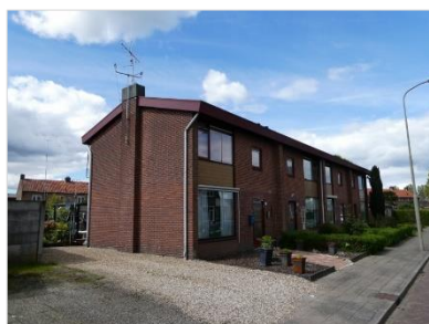
Figuur 2.31 Bebouwing aan de Enkweg (34-40).
