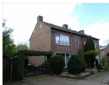
Figuur 2.5 Bebouwing aan de Rozenstraat (23 en 25).
