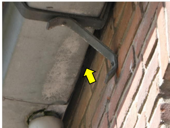
Figuur 4.6 Opening onder de dakgoot.
