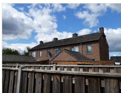
Figuur 2.4 Bebouwing aan de Rozenstraat (17-21).
