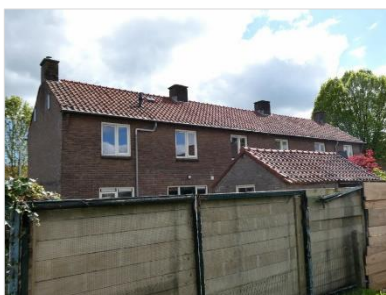
Figuur 2.10 Bebouwing aan de Enkweg (26-30).
