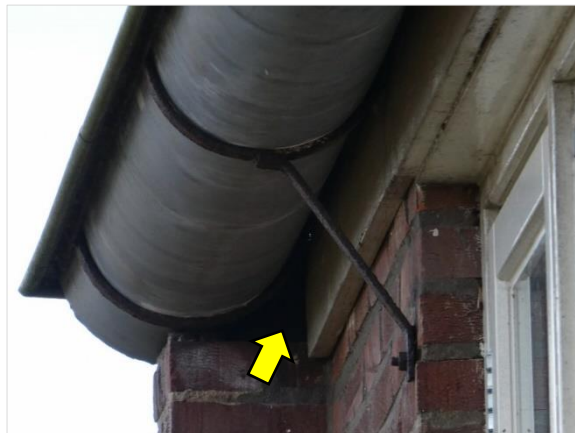
Figuur 4.2 Ruimte onder de dakgoot.
