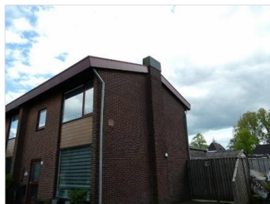
Figuur 2.24 Bebouwing aan de Steenbeekstraat (41-49).
