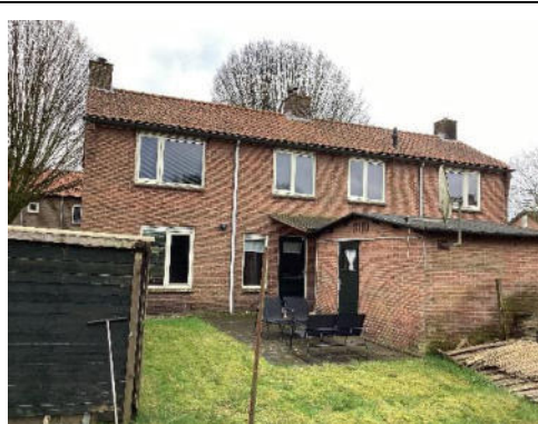
Foto 16 | foto voor boring 47
