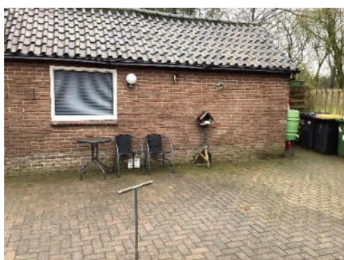
Foto 3 | foto voor boring 06
