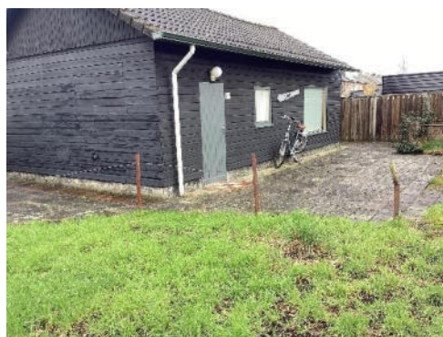
Foto 20 | foto voor boring 55
