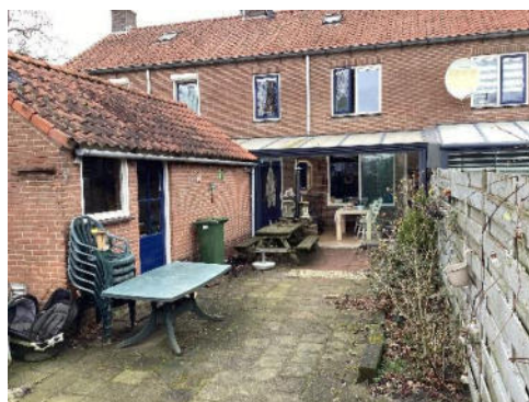
Foto 6 | foto voor boring 11
