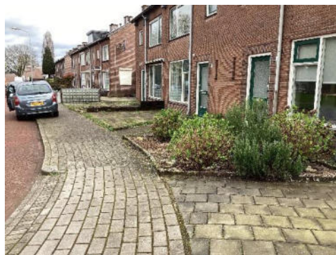
Foto 22 | foto voor boring 59
