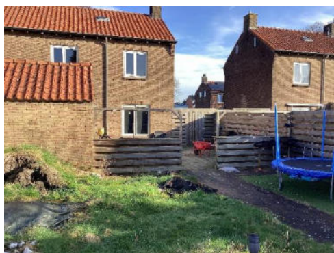
Foto 9 | foto voor boring 21
