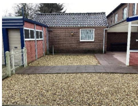
Foto 4 | foto voor boring 09
