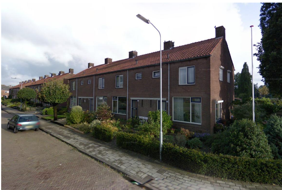
Huidige situatie van de te slopen woningen langs de Steenbeekstraat (bron: GoogleMaps).
