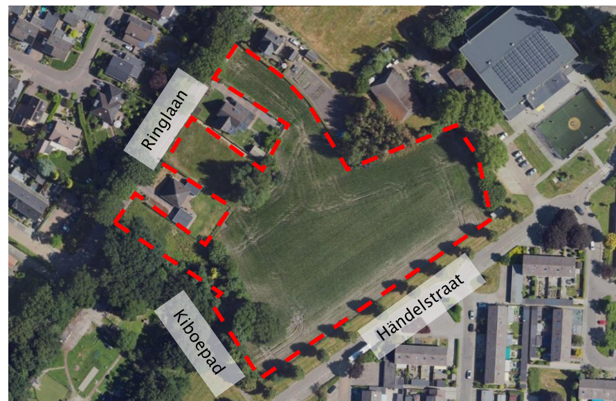
Figuur 1-1: Locatie plangebied (bron: Cyclomedia)
