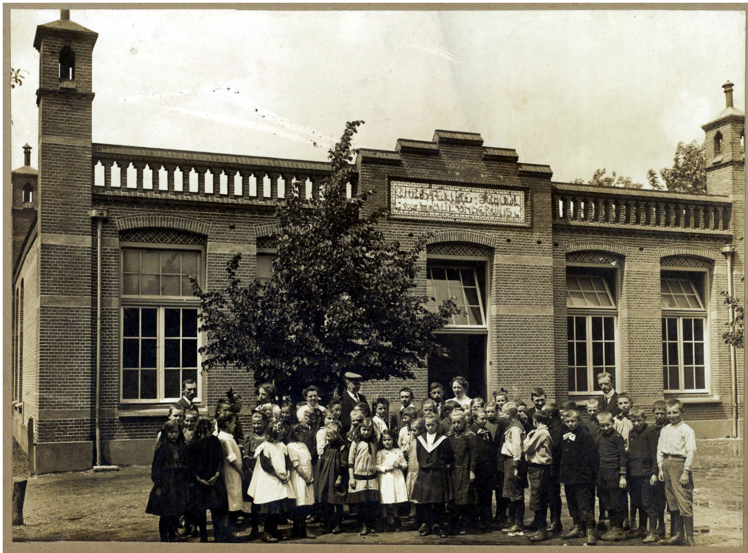
Figuur 6: Foto van het oude schoolgebouw in 1916 (Onbekend 1916).
