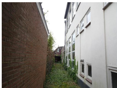
Aanzicht steeg ten westen van het schoolpand;
