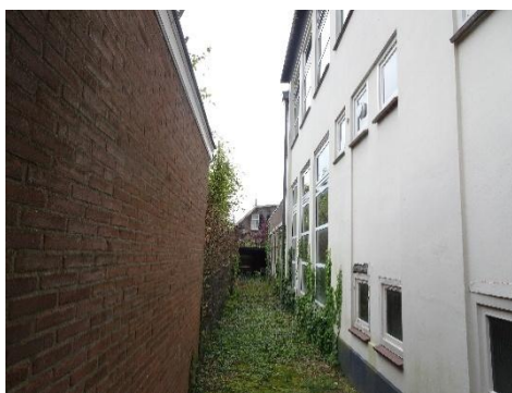
Aanzicht steeg ten westen van het schoolpand;
