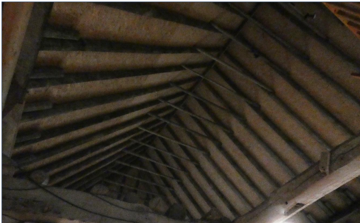
Figuur 3.2 De zolderruimte waar de lichtstraat gerealiseerd zal worden.
