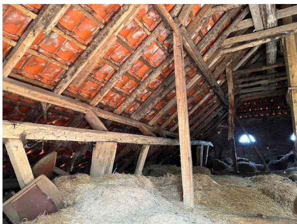
Figuur 12. Zolder van gebouw 4.
