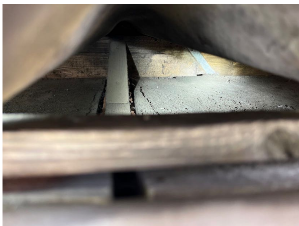
Figuur 13. Ruimte onder het dak van gebouw 2.
