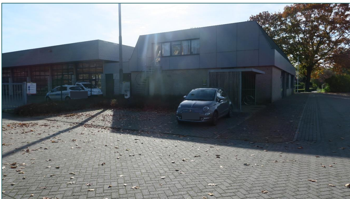
Figuur 4 Impressie van het parkeerterrein met op de achtergrond de brandweerkazerne. De gemetselde gevel beschikt over meerdere open stootvoegen.
