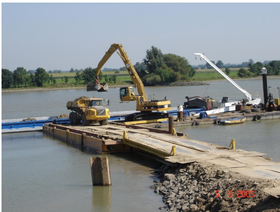
Foto 1. Kraan op ponton. Vrachtwagen op drijvende brug om geladen te worden.
