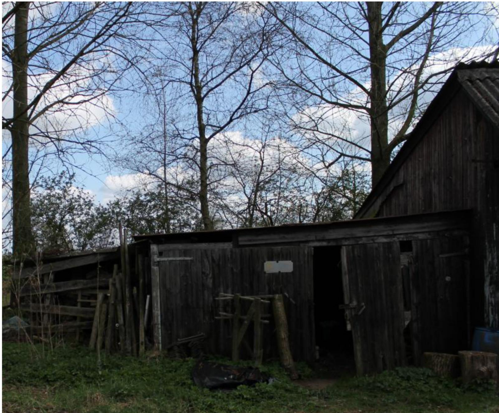
FIGUUR 4.3: AANZICHT TE SLOPEN BIJGEBOUW "MELKHOK".
