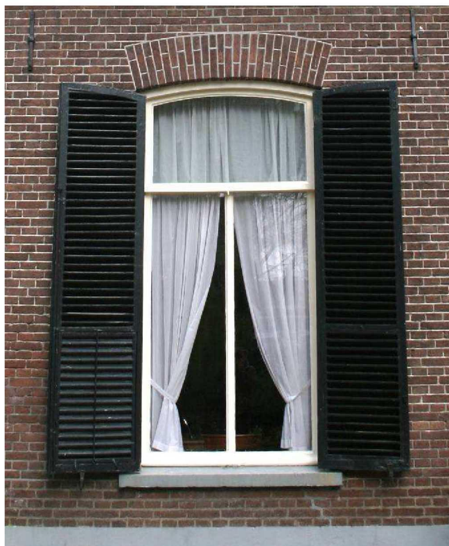
Raamkozijn t.p.v. de voorgevel
