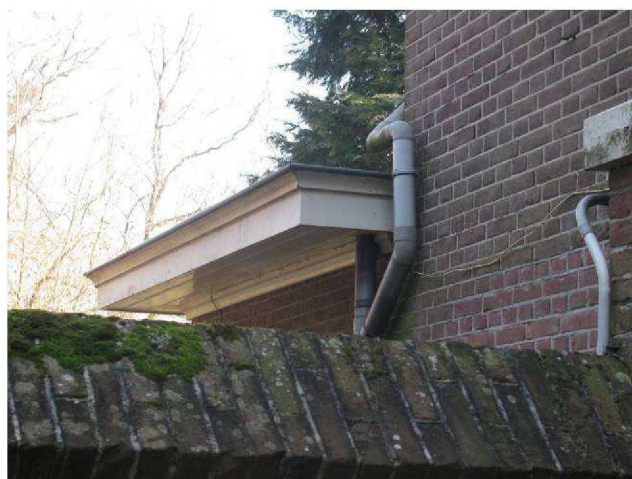
Kabels, hemelwaterafvoeren en leidingen geven een rommelig beeld.
