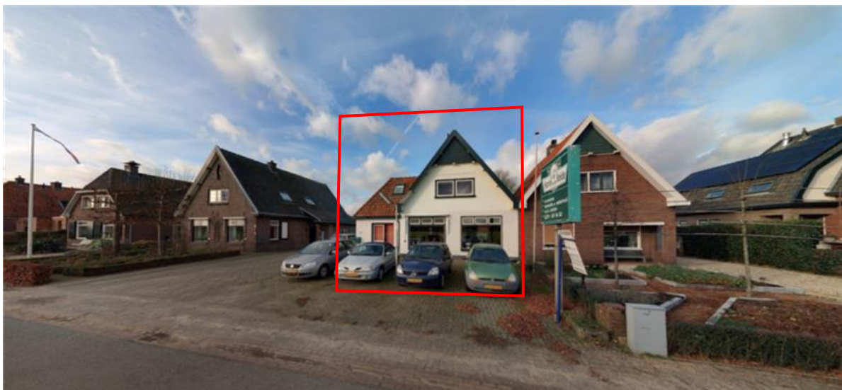
Figuur 8: De voorkant van het gebouw met de aanliggende panden. Het betreffende gebouw is voorzien van een rood kader (bron: StreetSmart).
