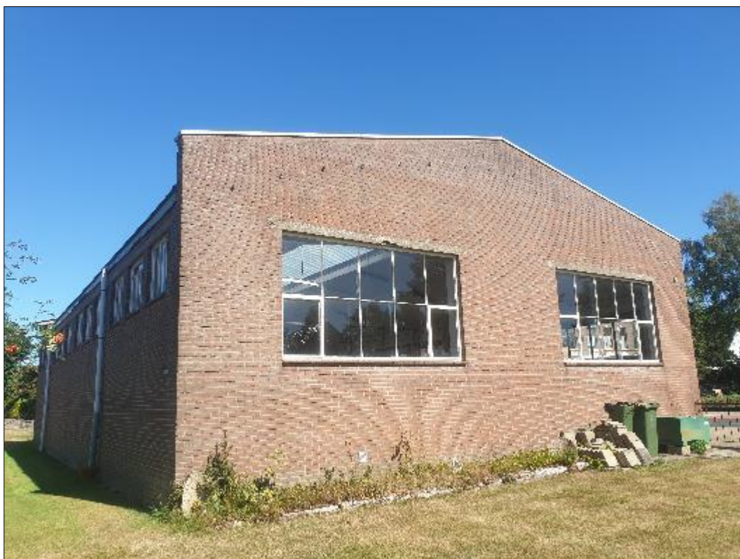
Afbeelding 2.5. Noordzijde te slopen loods.
