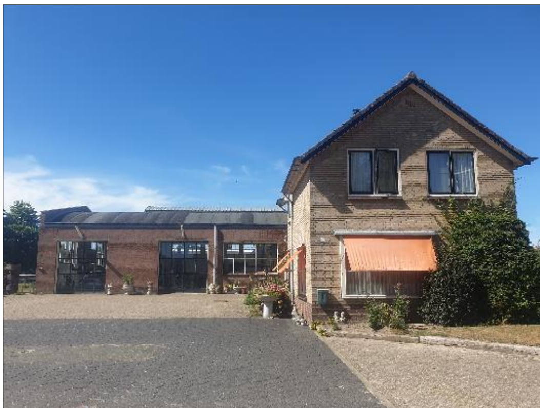
Afbeelding 2.3. Te slopen loods links en woning rechts (gezien vanaf straatzijde Emperweg).
