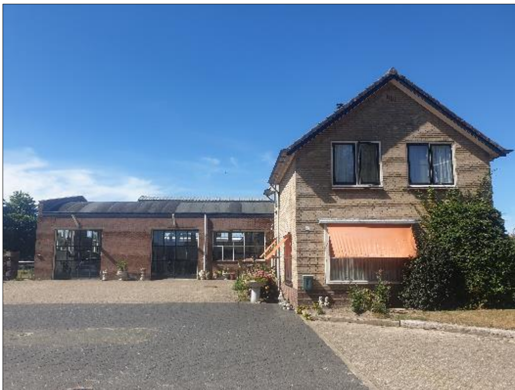
Afbeelding 1.3. Te slopen loods links en woning rechts (gezien vanaf straatzijde Emperweg).
