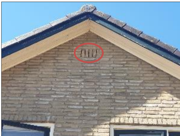
Figuur 4.6 Potentiële toegangsmogelijkheden tot verblijfplaatsen voor vleermuizen in de spouw (zie rode lijnen en cirkel).
