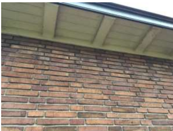
De betimmering van de overstek sluit naadloos aan op de buitengevel.
